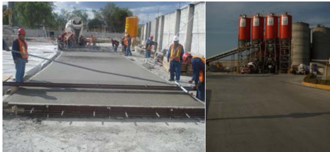
b) Pavimento Planta de Concreto, Tuf-Strand SF:4.5 kg/m 3
