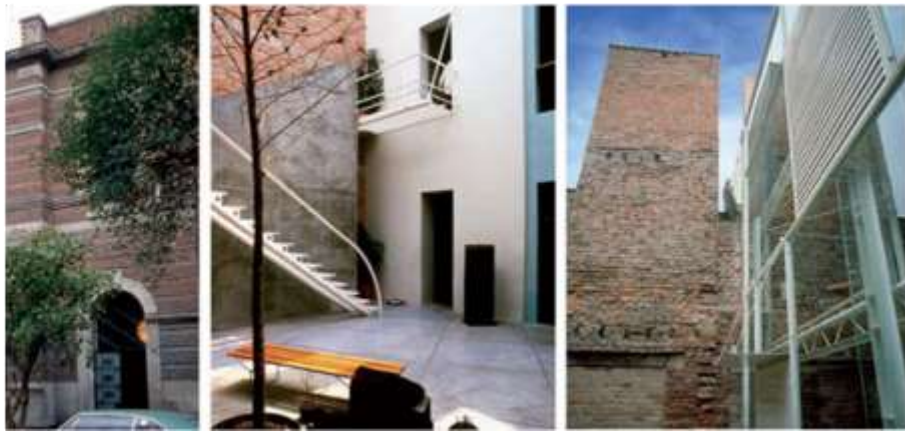
Proyecto de Rehabilitación. Sánchez Arquitectos y Asociados. Flora 20 Col. Roma México D.F La casa data de 1910 y su primera crujía y la fachada a la calle se conservaron en un estado original.
