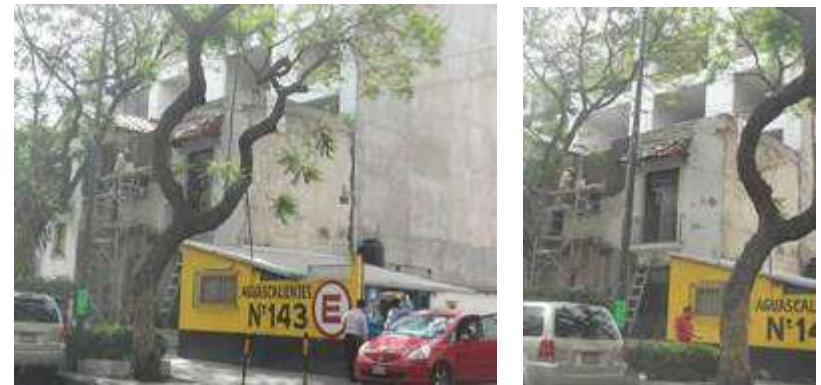
Proyecto de Rehabilitación. Aguascalientes 141 Col. Hipódromo Condesa México D.F La casa data de mediados del siglo XX y su primera crujía y la fachada a la calle se conservaron en un estado original, ocupando el resto del predio, para hacer torres de vivienda nueva de interés medio.
