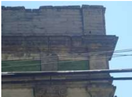
Agregado en la parte superior de la fachada.
