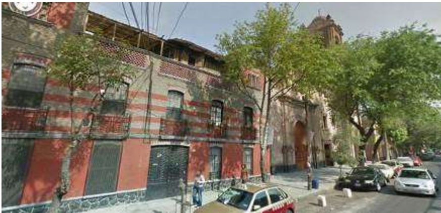
Cera Poniente. Parroquia del Espíritu Santo. Colindancia sur. Predio de 3 niveles y uso habitacional.
