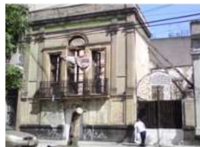
Fachada Principal. Sabino 189. Col. Santa María la Ribera
