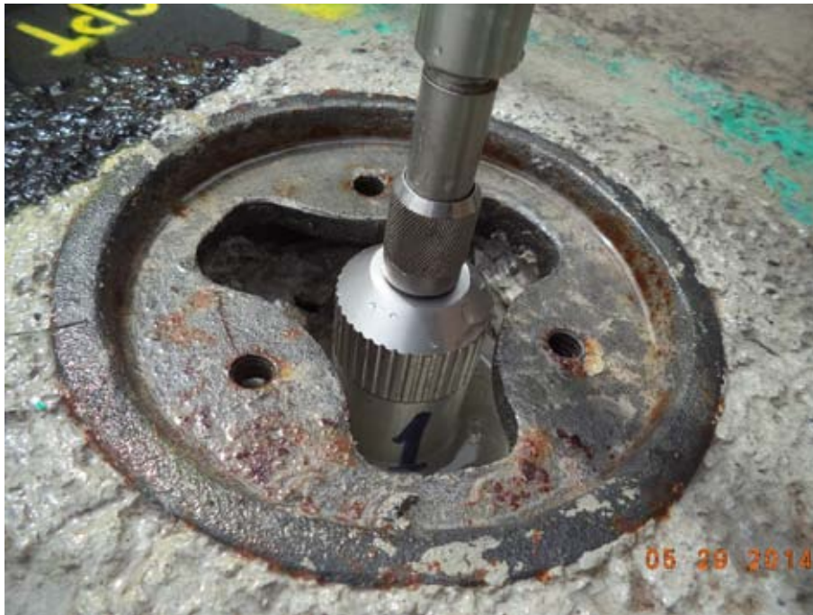
Figura A11. Posicionamiento del hombro de sonda a nivel de piso (prof. de adquisición de 2.5 m)
