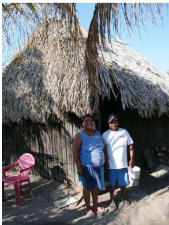
Foto 1. Casa tradicional de los pescadores de camarón, construida con paredes de chamalote 23 y techo de palma.
