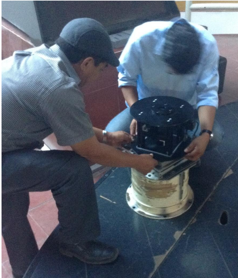
Figura 54 Colocación de extensión ya que no se cumple con la distancia requerida.
