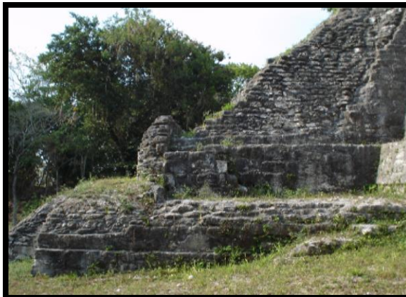
Fig. No. 55 Fotografía del edificio 216 D. Callén
