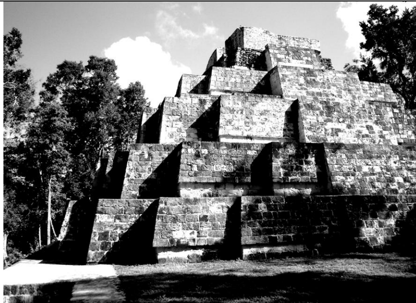
Fig. No. 13 En este caso, el trabajo de restauración del montículo real llegó más allá de donde llega la hipótesis, con la consecuente pérdida de autenticidad. Ya no es posible hacer modificaciones según aparezca nueva evidencia. Por el contrario, la modelación virtual se ofrece como una alternativa científica válida para expresar una supuesta realidad del monumento en su época de uso.
