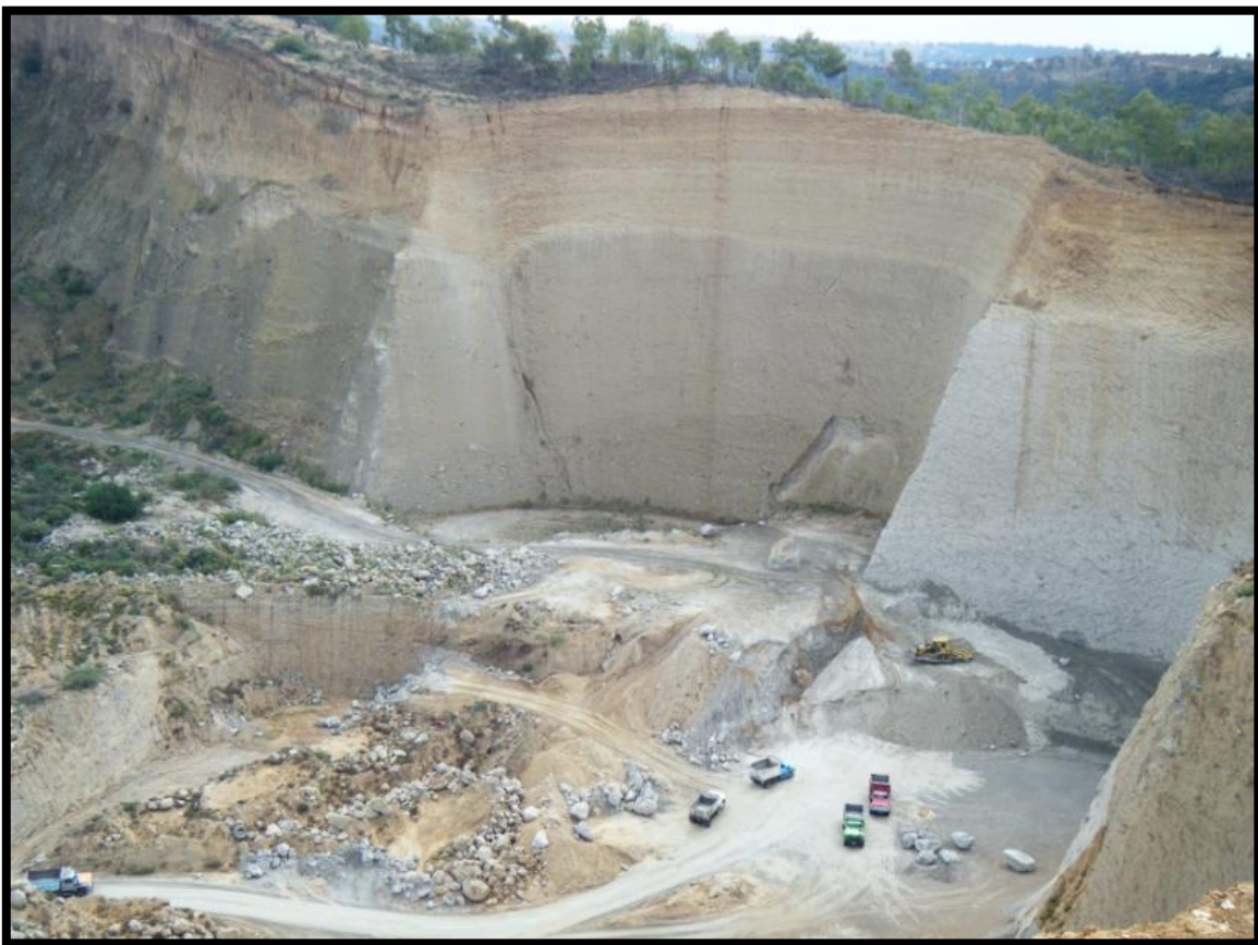
Figura 18. Minado de Ladera en la mina El Potrero
