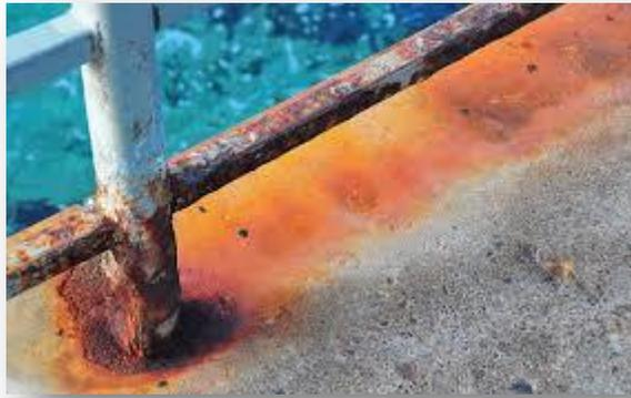
Figura 2.5. Corrosión uniforme
