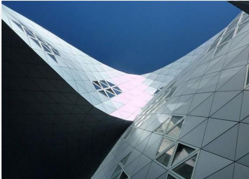
**Figura 2.14. Anodizado arquitectónico**
