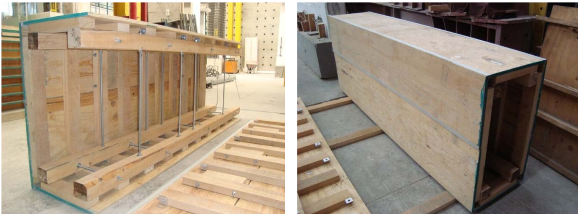
Figura 4.6. Armado de los paneles internos de la cimbra para la pila
