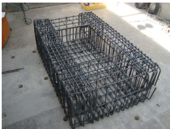
Figura 4.1. Armado del acero de refuerzo de la zapata de los especímenes
