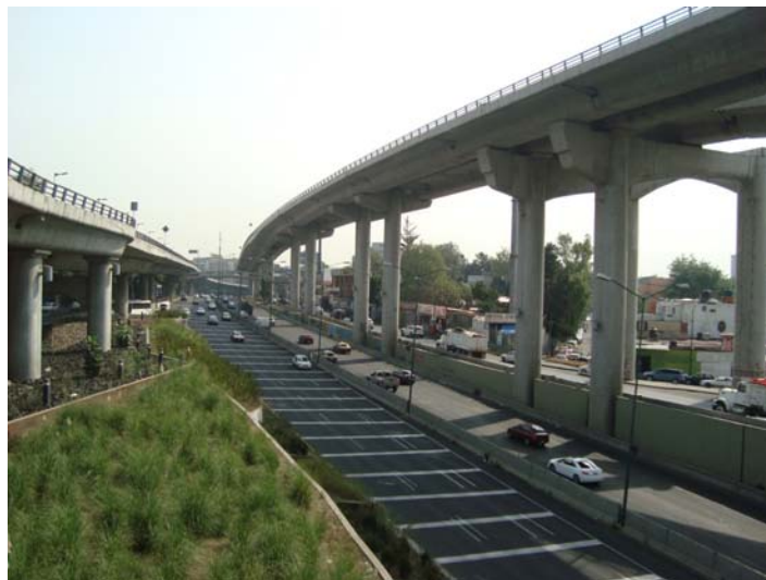
Figura 1.1. Autopista a desnivel Periférico, ciudad de México
