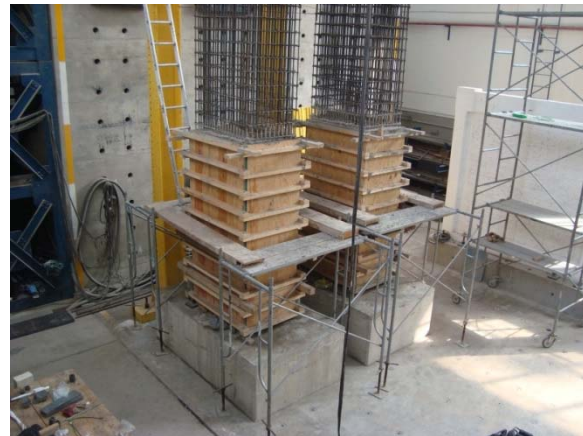
b) Segunda etapa de colado (pila)
