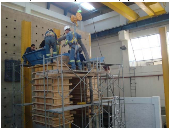
c) Tercera etapa de colado (pila)
