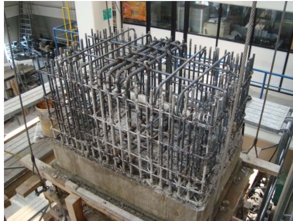
Figura 4.3. Armado del acero de refuerzo del cabezal macizo de los especímenes
