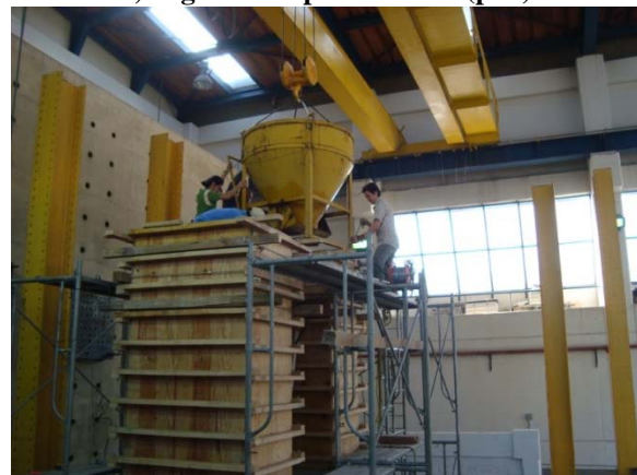
d) Cuarta etapa de colado (cabezal macizo)
