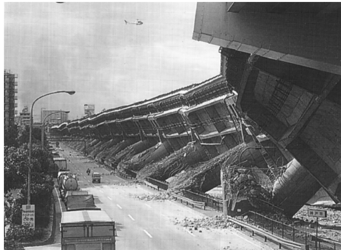
Figura 1.2. Falla de pilas del puente Hanshin expressway, Kobe 1995 (Iwasaki, 1996)
