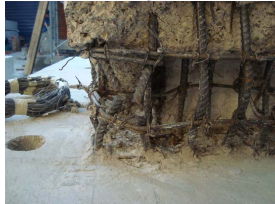
d) Fractura de barras longitudinales (Sureste)
