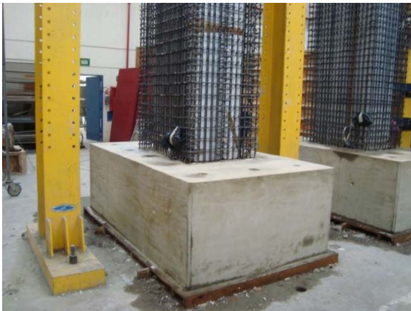
a) Primera etapa de colado (zapata)
