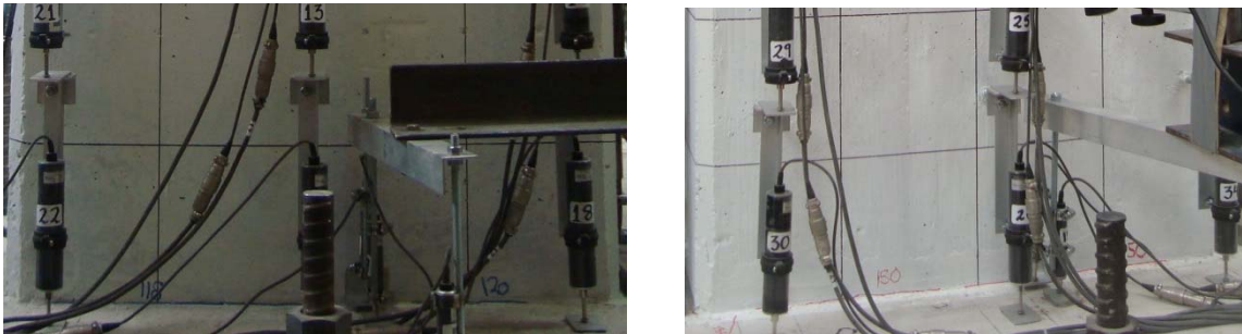
a) Cara Este b) Cara Oeste Figura 5.60. Primeras grietas de flexión de espécimen PH5
