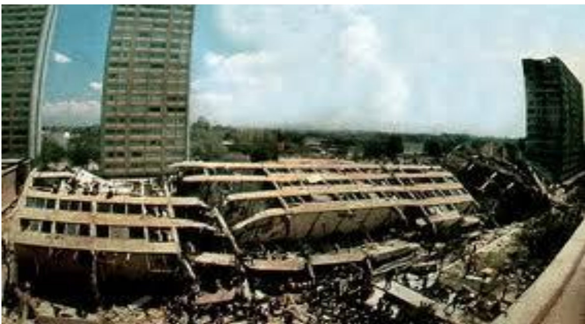
Figura 4.- Colapso total de algunos de los edificios de la unidad habitacional Tlatelolco.
