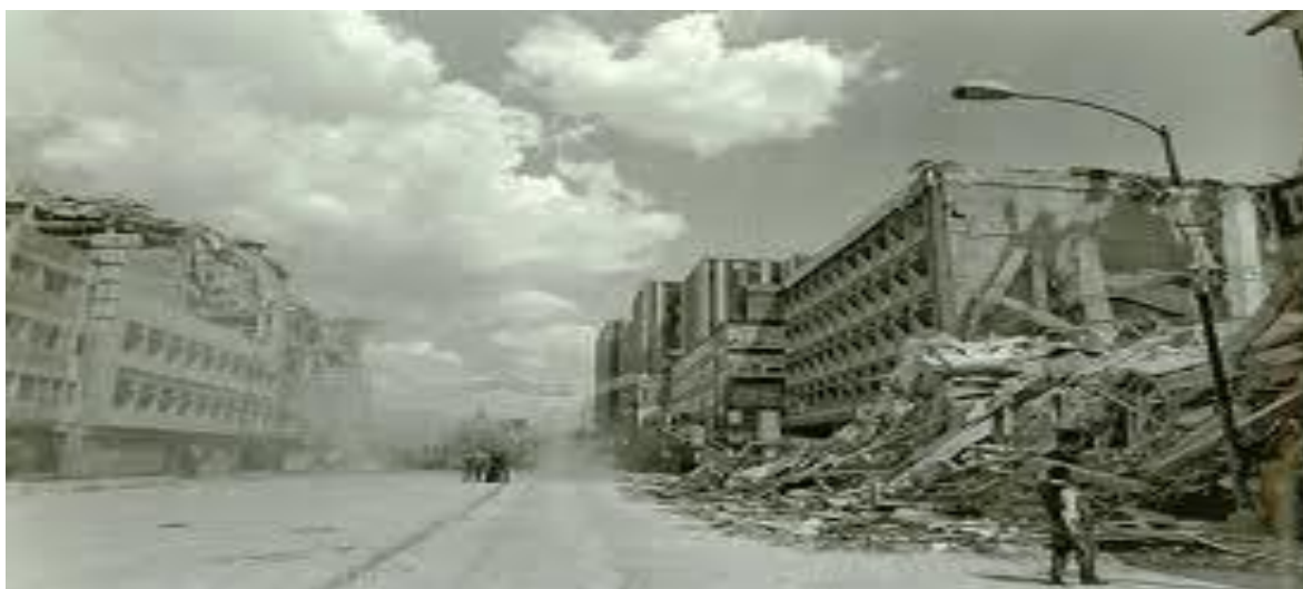
Figura 3.- Así quedaron los edificios del centro del Distrito Federal.
