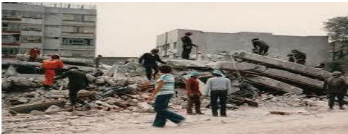
Figura 1.- Edificio derrumbado y humeante en la calle San Juan de Letrán en el Distrito Federal
