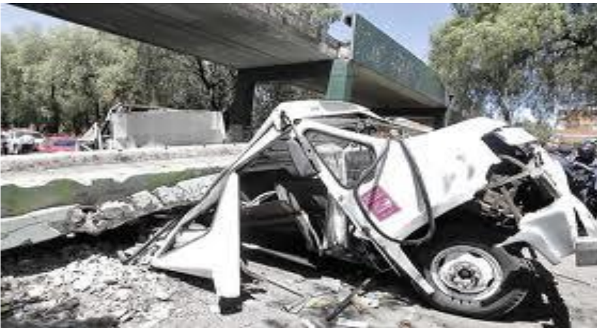
Figura 5.- Daños en puentes, vehículos del sismo de 1985 en la Ciudad De México.
