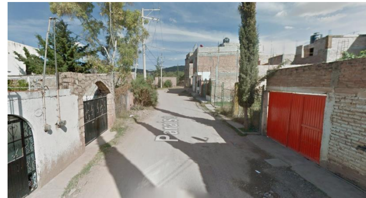
Calle paraíso parte norte de la zona de estudio en esta imagen se nota la falta de pavimento en la calle y la falta de armonía en las construcciones de la zona
