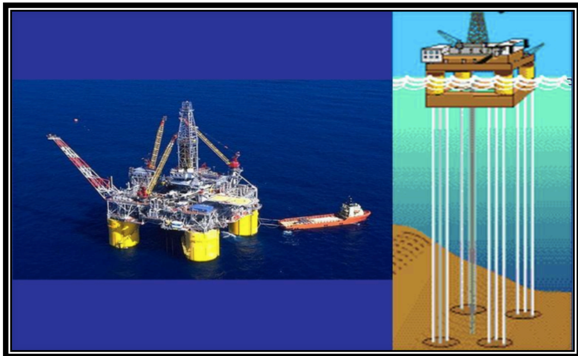
Figura 1.7. Plataforma con piernas tensionadas. (Rodríguez, N.J; 2009).
