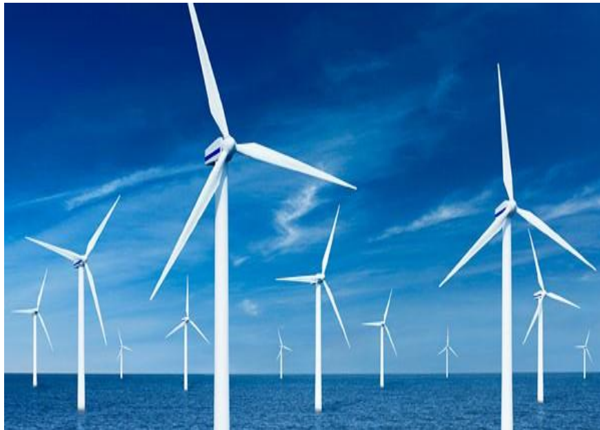
Ilustración 9. Aerogenerador Moderno capaz de abastecer 2500 hogares Fuente: http://evolution.skf.com/es/sistema-de-lubricacion-centralizada-mas-eficiente-para-aerogeneradores/
