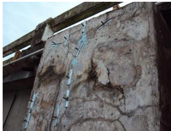
Figura 1.13. Inyección de resina epóxica en bloques de anclaje [1.3].
