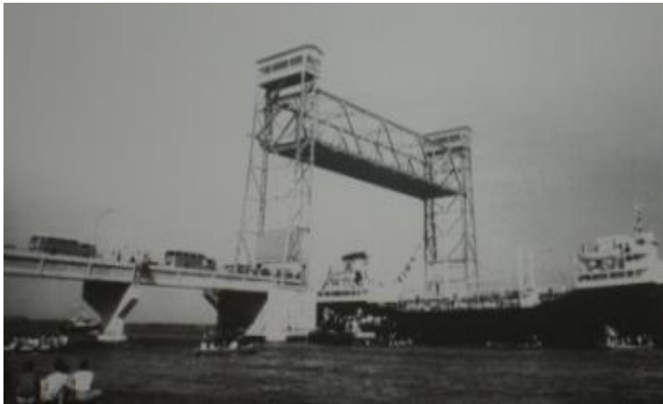
Figura 1.8. Puente Coatzacoalcos I, se observa la utilidad de su tramo levadizo [1.3].
