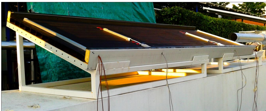
Figura 2.16 Se observan en la parte central los termopares de superficie TJ09-TJ12 y las canaletas bajo las cuales se encuentran los termopares TT01-TT04 para la medición de la temperatura del aire a la entrada (lado izquierdo), y los termopares TT05-TT08 para la medición de la temperatura del aire a la salida (lado derecho).
