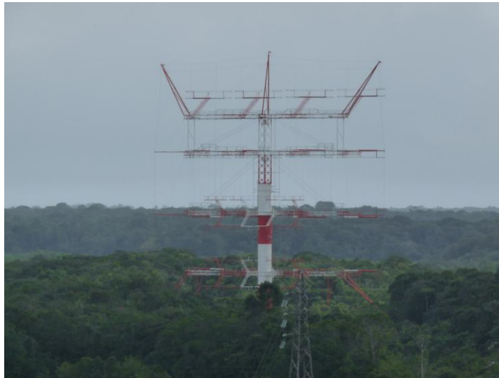
Figura 2.3: Antena ALLISS en la estación de Montsinery.
