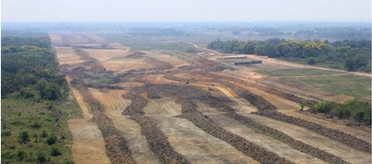
Figura 29. Construcción del nuevo aeropuerto de palenque, (Gobierno de Chiapas)
