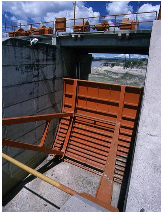
Ilustración 5.8. Compuerta radial de la Presa “Temascal”
