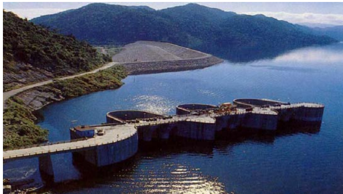
Ilustración 5.10. Vista superior de la Presa “Cerro de Oro”
