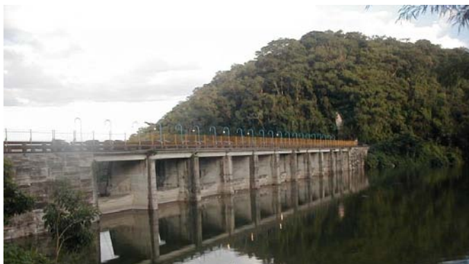
Ilustración 5.6. Vista de la parte posterior de la obra de excedencias de la Presa "Temascal".
