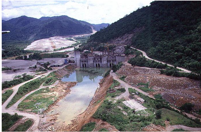
Ilustración 5.9. Construcción de la Presa Miguel de la Madrid “Cerro de Oro”.
