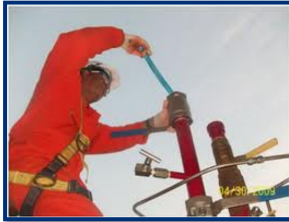
Figura 17. Introducción de una barra espumante a un pozo
