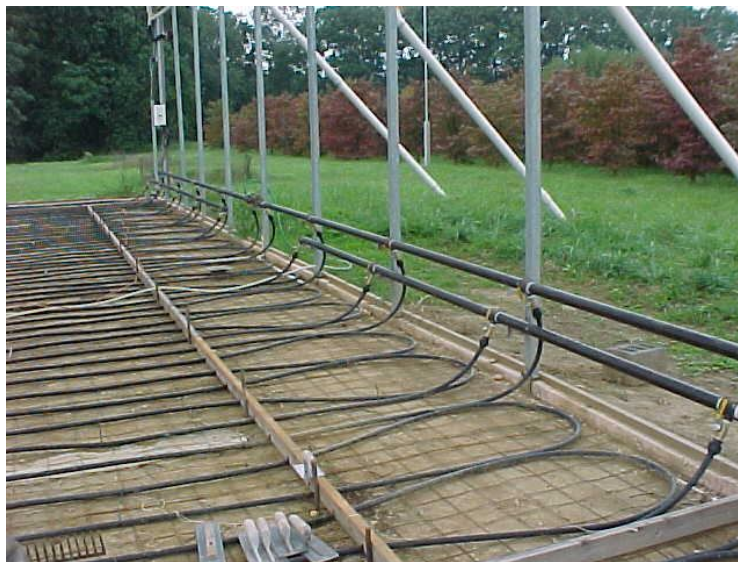
Figura 21. Piso térmico generado por la circulación de agua caliente en tuberías de polipropileno.
