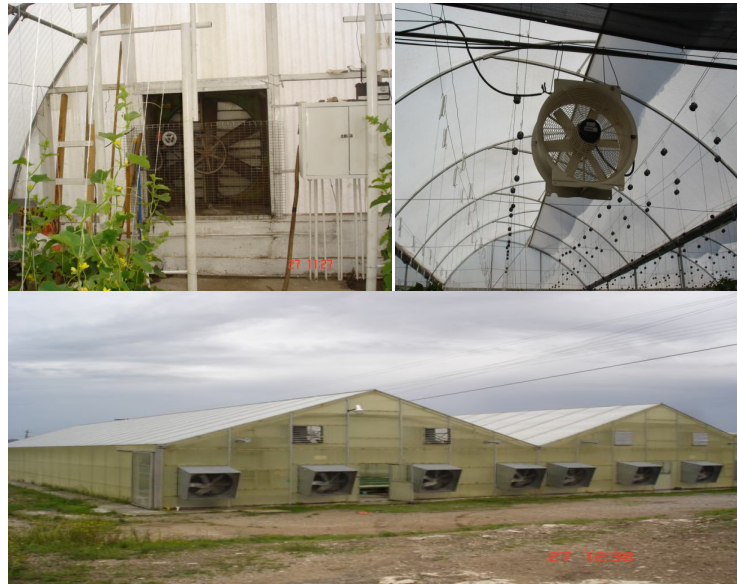
Figura 27. Ventilación forzada por medio de ventiladores y extractores.
