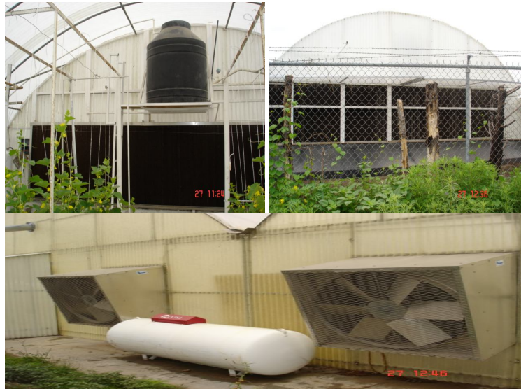
Figura 28. Ventilación forzada por medio de paredes húmedas.
