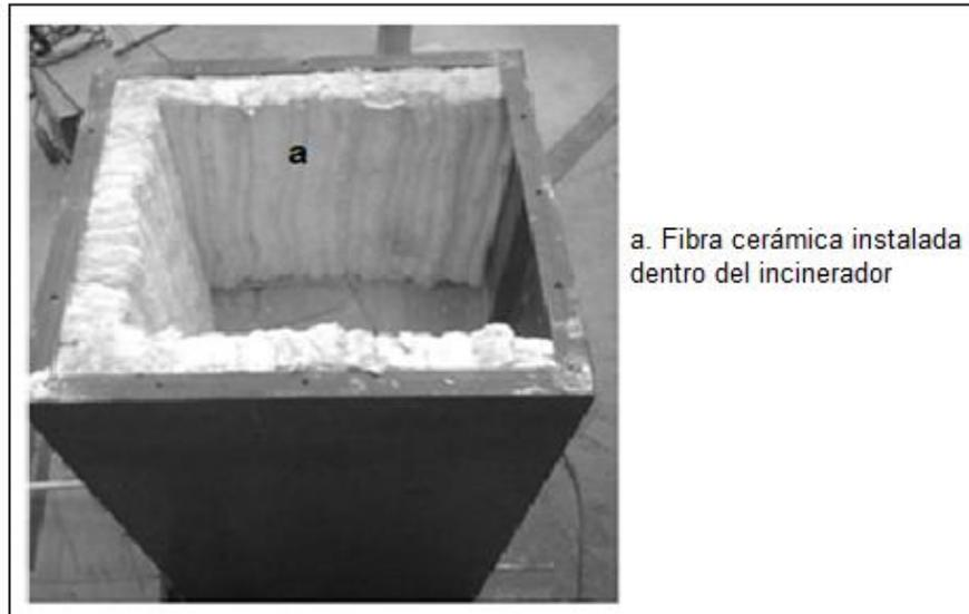
**Figura 4.10 Instalación de fibra cerámica dentro del incinerador**
