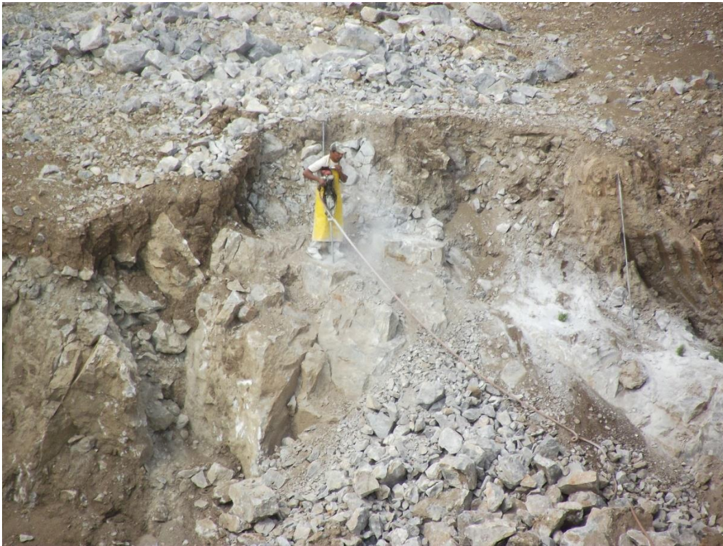
Figura IV- 6 Barrenación con maquina neumática.
