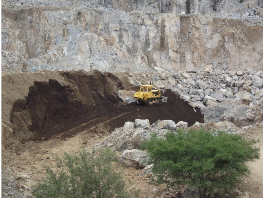
Figura V- 8 Trascabo construyendo un camino.
