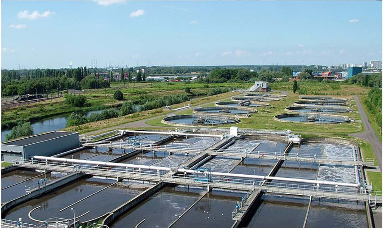
Fotografía 6. “Estación depuradora de aguas residuales en Amberes, Bélgica”
