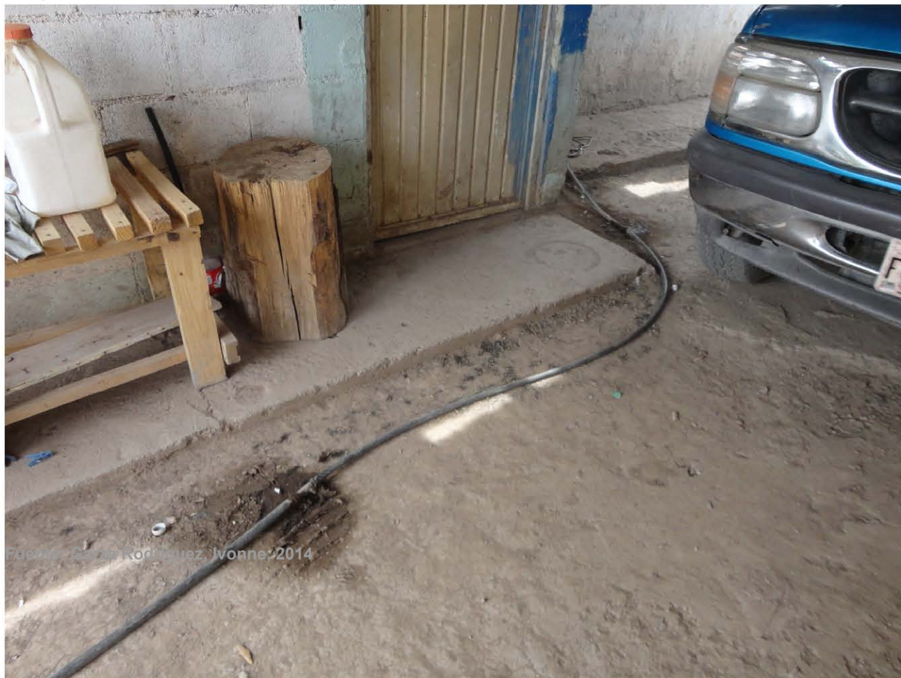
Fotografía 32. Manguera flexible para distribución de agua en una vivienda del Dieciocho
