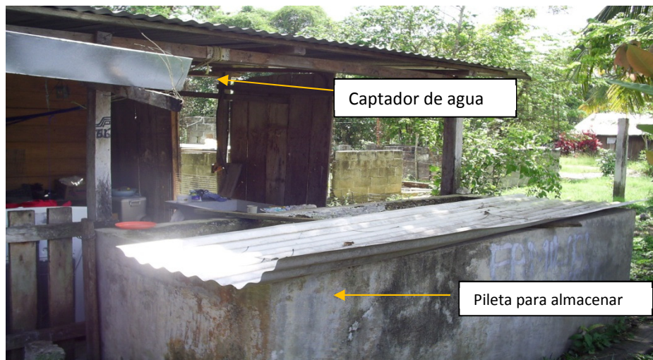
Figura 14 . Captadores y piletas para almacenamiento de agua
