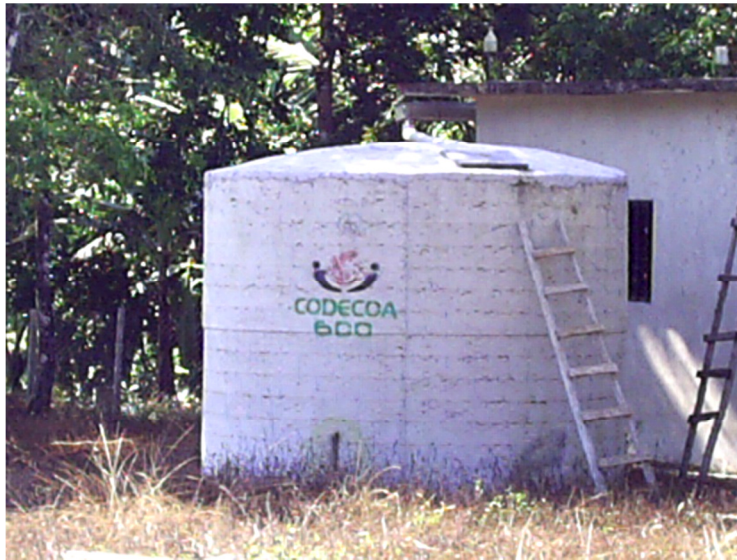
Figura 13 . Tanque para captar agua en temporada de lluvia
