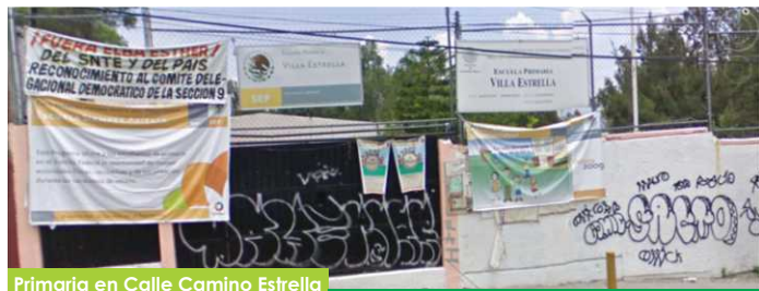
Primaria en Calle Camino Estrella
