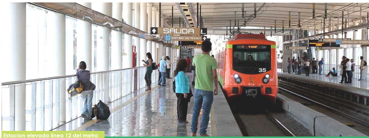
Estación elevada línea 12 del metro
