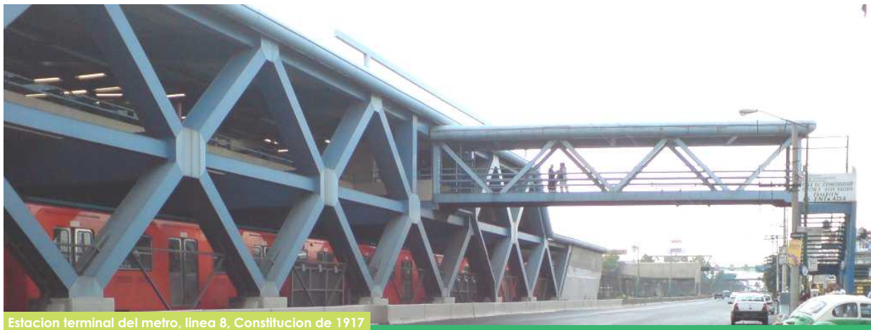
Estación terminal del metro, línea 8, Constitución de 1917
