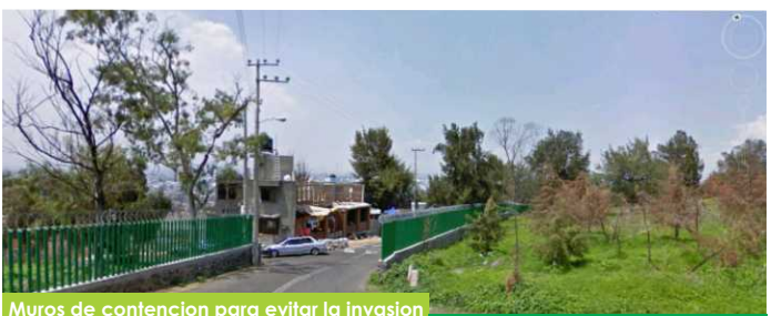
Muros de contencion para evitar la invasion
