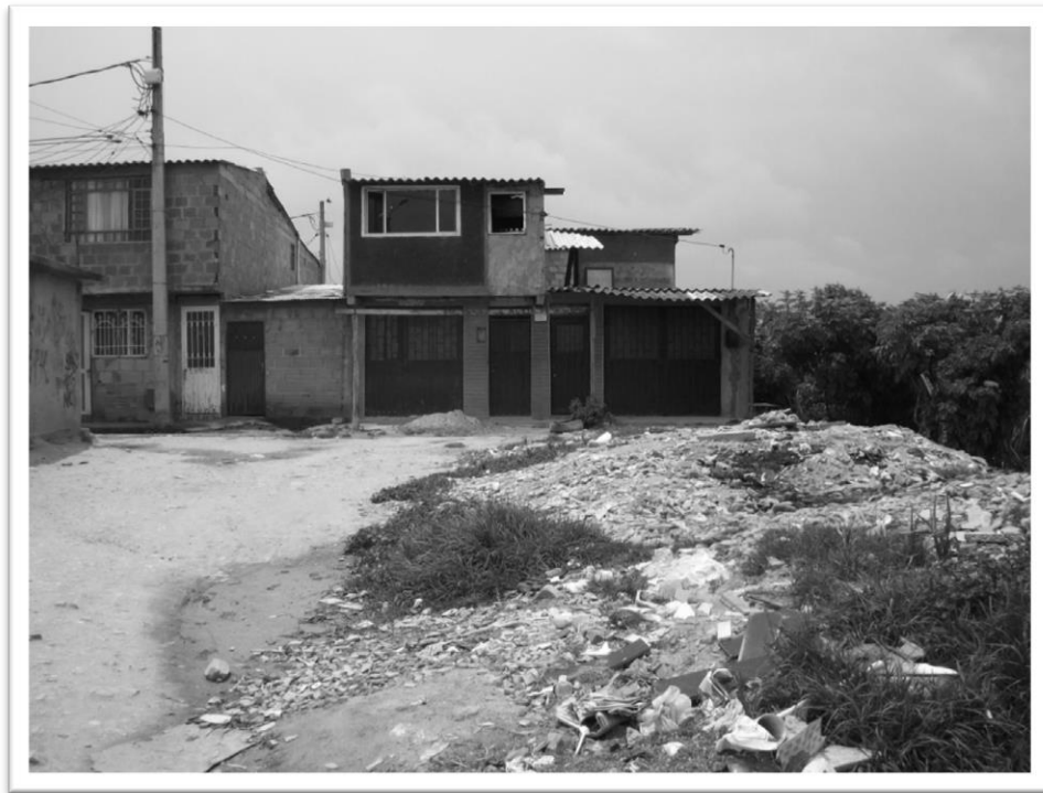
Foto 7. Vivienda Social localizada en orillas del Humedal Tierra Blanca. Barrio Arizona.
