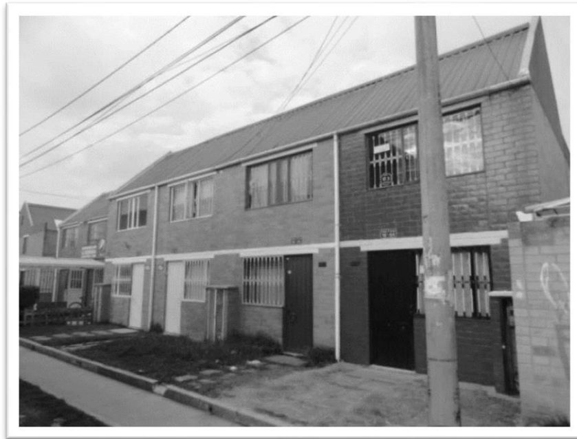
Foto 2. Vivienda formal de origen institucional estatal en el barrio Villa Italia, de la zona de influencia inmediata del Humedal Tierra Blanca.
