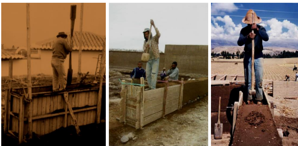
Imagen 27. Construcción de muros de tapia, con apisonado de tierra húmeda en cimbras de madera.
