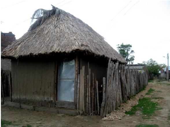
Imagen 46. Vivienda edificada con bahareque y techo de paja en el Peñón, Colombia.
