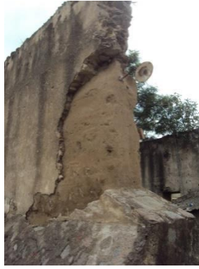
Imagen 196. Muros de tapia con pérdida de recubrimientos de mampostería y aplanados en las zonas de servicios de la hacienda Soltepec. Fuente: Imágenes de autor.
