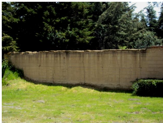
Imagen 197. Uso de tapia en construcciones modernas. El muro perimetral del nuevo fraccionamiento se erigió con tapia, la cimbra se colocó con textura para dar la impresión de sillares. Fuente: Imágenes de autor.
