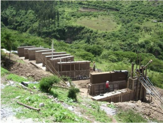
Imagen 235. Construcción de casa entre muros en Quito, Ecuador, con muros de tapia en un terreno de 5000 m 2 .
