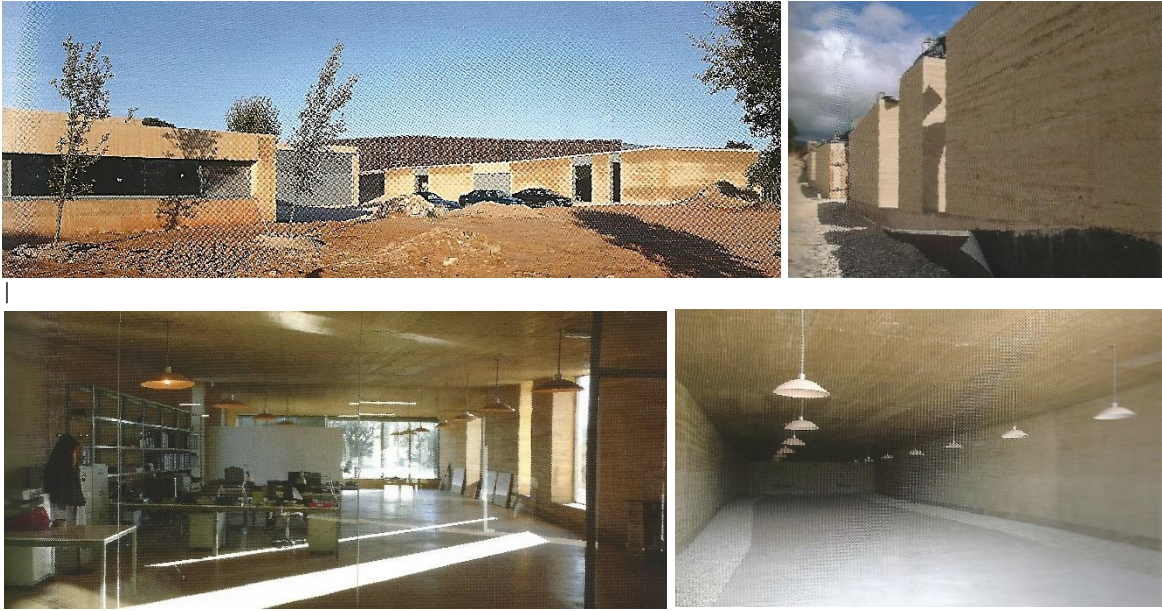
Imagen 227. Bodega en Lanciego, España, (2008), la construcción se desplantó en el terreno por medio de unas naves semienterradas y el producto de la excavación se utilizó para la erección de los muros. Fuente: Fermín Font, Arquitecturas de tapia , p. 157.
