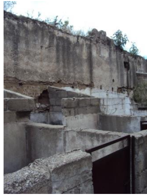
Imagen 196. Muros de tapia con pérdida de recubrimientos de mampostería y aplanados en las zonas de servicios de la hacienda Soltepec. Fuente: Imágenes de autor.
