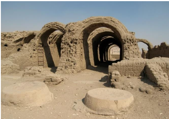
Imagen 1. Almacenes del templo de Ramses II, en Egipto que tienen una antigüedad de más de 3000 años y fueron edificados con adobes, hechos a base de tierra cruda.
