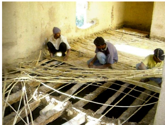
Imagen 33. Colocación de cubierta por medio de la ejecución de cañizo sobre los troncos. Fuente: Vicent Soriano, Arquitectura de tierra en el sur de Marruecos , p. 80.
