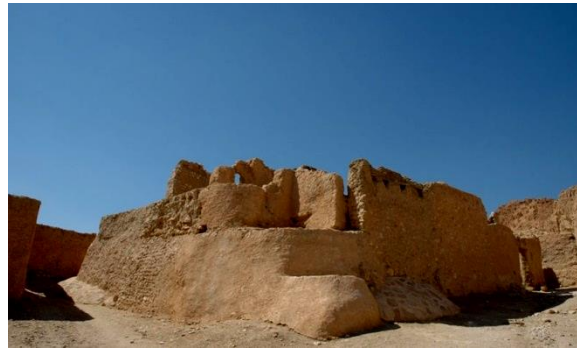
Imagen 35. Construcción de adobe y tapia en la frontera de Túnez con Argelia.
