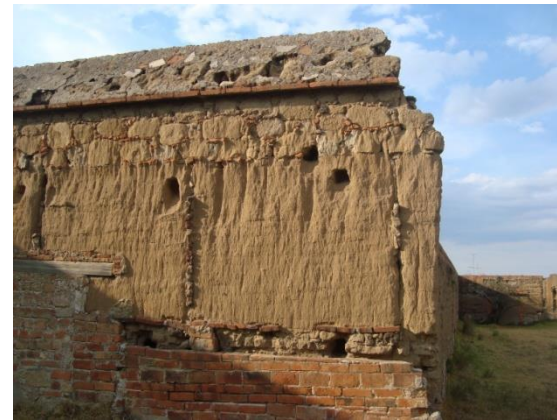
Imagen 211. Avanzado estado de deterioro en los muros de tapia con conforman los espacios de la hacienda, la pérdida de recubrimientos y cubiertas ha originado la erosión y disgregación. Fuente: Imágenes de autor.
