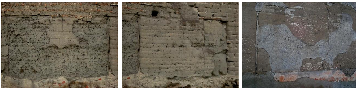
Imagen 173. Secciones de tapia en los muros perimetrales de la hacienda San Nicolás el Grande.
