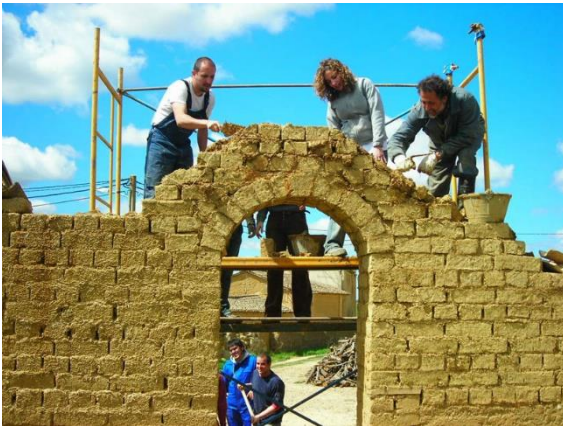
Imagen 239. Construcción de muros con tierra cruda utilizando materiales de origen natural.
