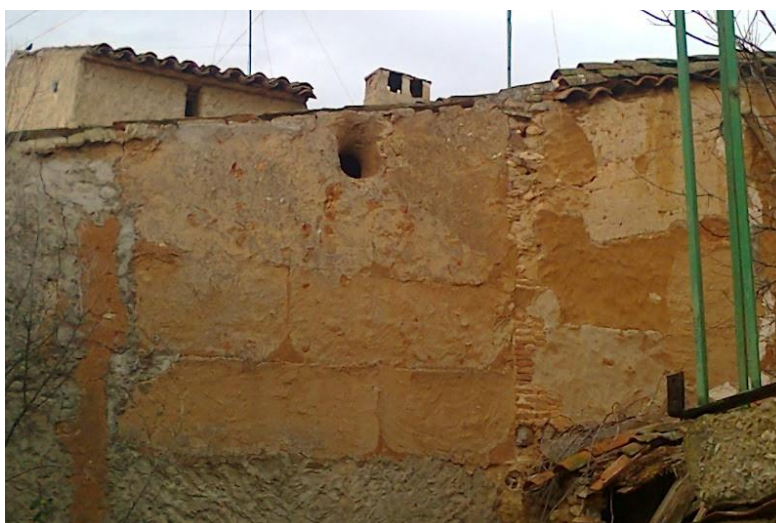
Imagen 43. Muro de tapia con aplanado de yeso en una casa en la Calle Baja del Barrio Bajo, Plasencia, Zaragoza, España.
