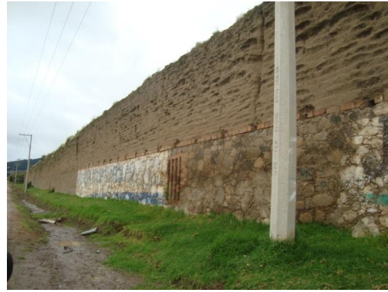
Imagen 209. Acceso posterior de la hacienda, fechado en 1883 y muros perimetrales edificados con mampostería y tapia, que presentan en algunas secciones un avanzado deterioro. Fuente: Imágenes de autor.
