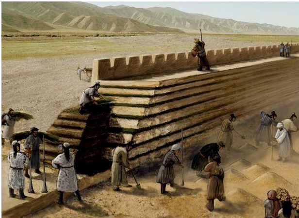
Imagen 8. Representación del proceso de construcción de la Muralla China encontrada, en el que se usó como estructura la tierra apisonada que se cubrió con piedras. Fuentes: Ren Chao, National Geographic China.
