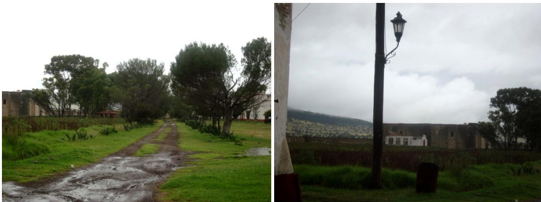
Imagen 167. Patio principal de la hacienda San Nicolás el Grande, el cual tiene alrededor las construcciones, destacando la troje, edificada con mampostería. Fuente: Imágenes de autor.
