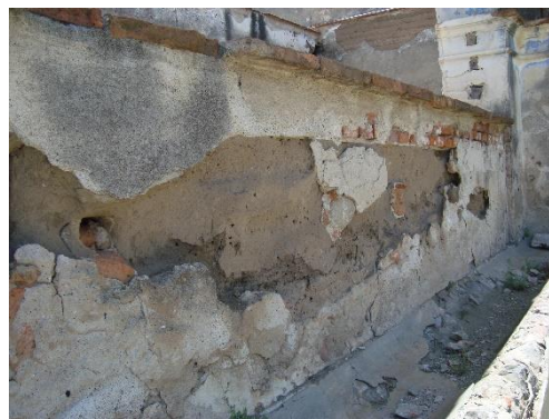
Imagen 231. Vulnerabilidad y deterioros de la arquitectura de tierra por falta de mantenimiento.
