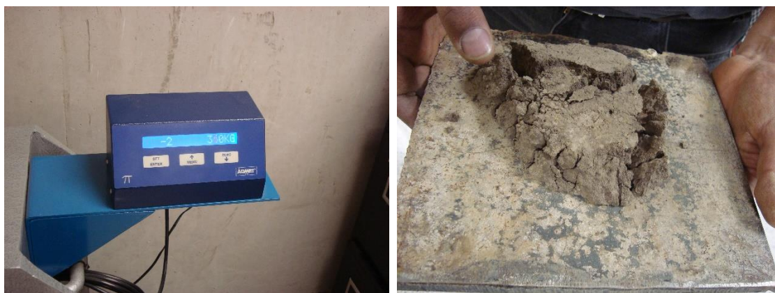
Imagen 219. Resultados de la compresión aplicada a cada una de las muestras obtenidas en los muros de tapia en ruinas de las haciendas seleccionadas.
