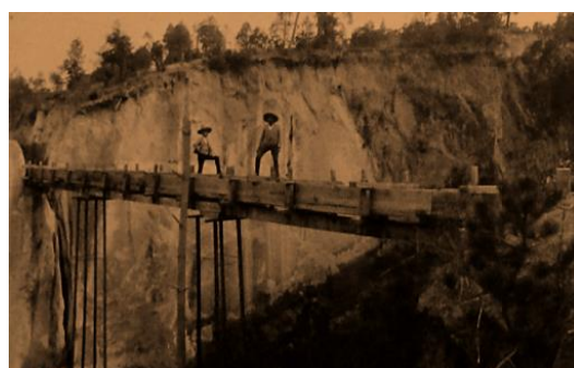
Imagen 92. Uso de la madera en Acueducto de la Sierra Nevada, en 1903.
