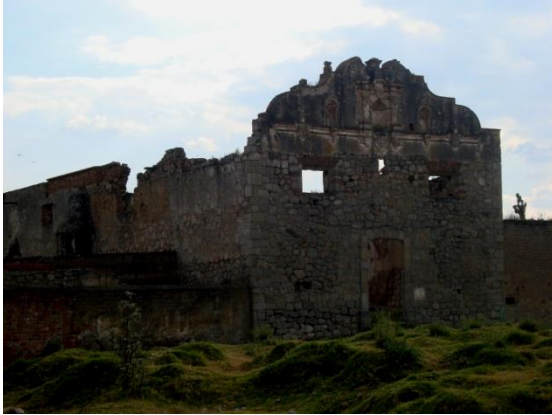
Imagen 203. Fachada principal de una de las tres capillas con remate mixtilíneo, la cual fue edificada casi en su totalidad con mampostería y en algunas secciones con adobe. Fuente: Imágenes de autor.
