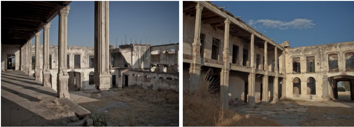
Imagen 200. Vistas de la casa grande constituida por dos plantas y patio principal de la hacienda San Antonio Mazapa.
