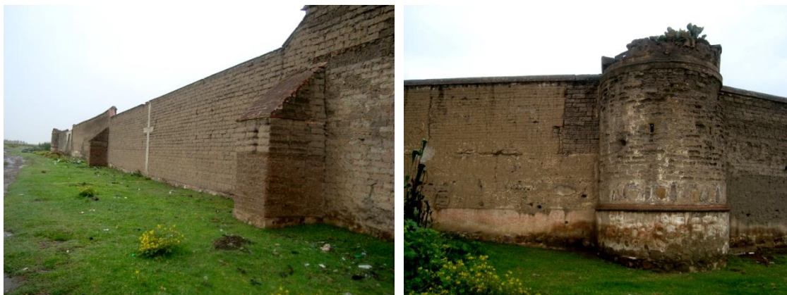
Imagen 171. Contrafuertes y torreón en la fachada posterior, en la que los muros son de adobe y tapia.
