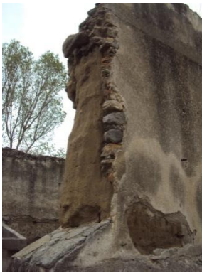
Imagen 196. Muros de tapia con pérdida de recubrimientos de mampostería y aplanados en las zonas de servicios de la hacienda Soltepec. Fuente: Imágenes de autor.
