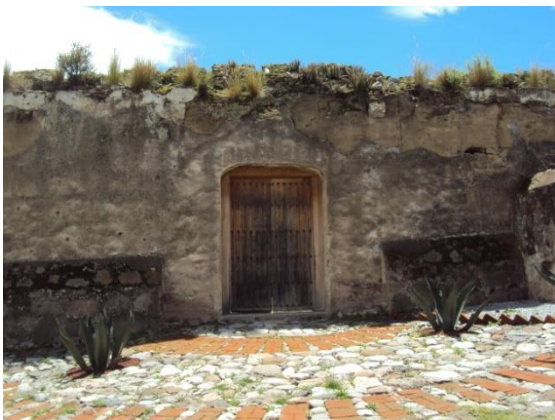
Imagen 194. Presencia de tapia en los muros de la hacienda San Francisco Soltepec, Huamantla, Tlaxcala.
