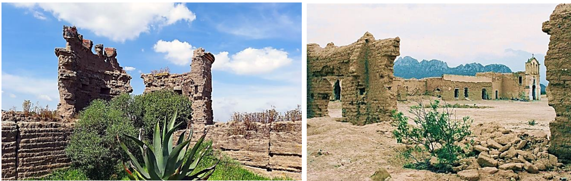
Imagen 29. Diferencia entre muro edificado con tapia y muro construido con adobe, se puede ver en el primer caso (Hacienda San Antonio Mazapa, Tlaxcala) la estructura de un muro monolítico, mientras que en el segundo (San Antonio de Arista, Nuevo León) se aprecian las piezas colocadas una por una, con juntas en cada segmento.
