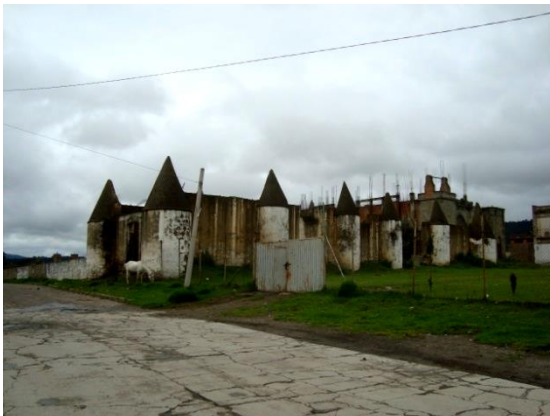
Imagen 208. Fachada y vista interior de la troje en la hacienda San Antonio Mazapa que actualmente se encuentra sin cubierta y se intentó intervenir en algún momento con concreto, ya que tiene el armado de unos castillos en el interior.
