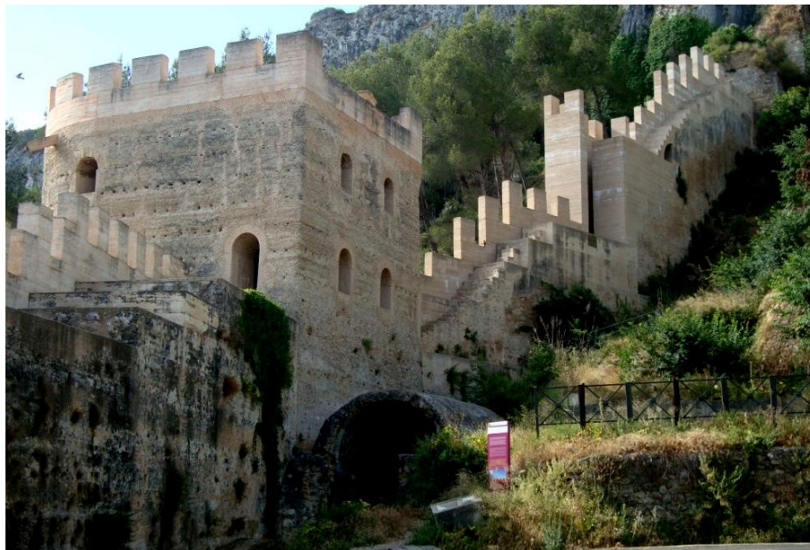
Imagen 44. Muros de tapia en el castillo de Xàtiva, España, en el almenado superior se aprecia la reciente intervención de consolidación de las tapias.
