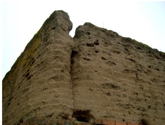
Imagen 211. Avanzado estado de deterioro en los muros de tapia con conforman los espacios de la hacienda, la pérdida de recubrimientos y cubiertas ha originado la erosión y disgregación. Fuente: Imágenes de autor.
