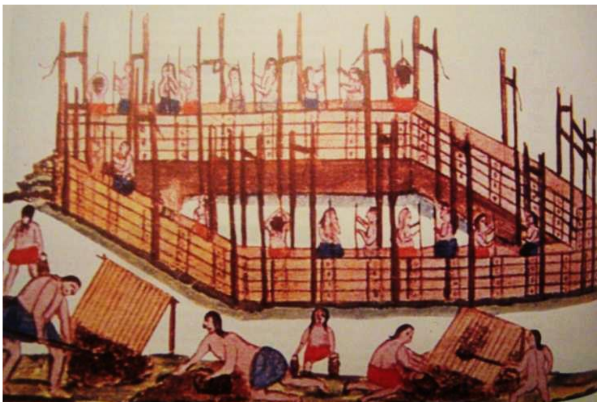
Imagen 7. Modo como levantar muros con tierra apisonada; la tablazón se va corriendo hacia arriba por los postes.” P. Florian PankeS.J.
