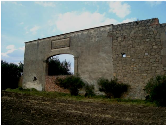
Imagen 209. Acceso posterior de la hacienda, fechado en 1883 y muros perimetrales edificados con mampostería y tapia, que presentan en algunas secciones un avanzado deterioro. Fuente: Imágenes de autor.
