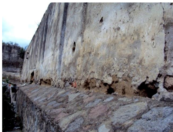
Imagen 118. Muros de tapia en áreas de servicios en la hacienda San Francisco Solpepec, Huamantla, Tlaxcala.
