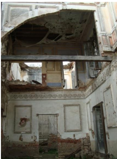
Imagen 205. Interior de la casa grande que se encuentra deteriorada, ha sido saqueada y ha perdido cubiertas, puertas, ventanas y secciones de muros. Fuente: Imágenes de autor.
