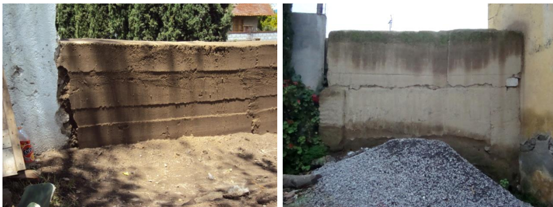
Imagen 198. Restitución de muros de tapia con la misma técnica constructiva, empleándose a materia prima del sitio.
