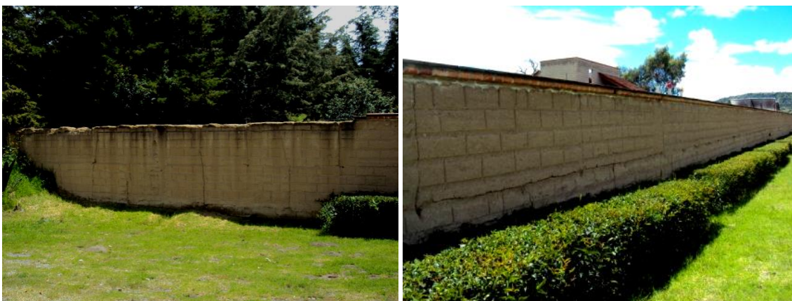
Imagen 120. Construcción de muros de tapia perimetrales (el diseño de la cimbra simula sillares) en el nuevo fraccionamiento de la hacienda San Francisco Soltepec, Huamantla, Tlaxcala, cuya distribución se asienta en los terrenos que fueron la zona de cultivo. Fuente: Imágenes de autor.
