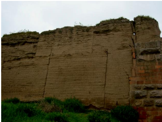
Imagen 210. Muros perimetrales de la hacienda San Antonio Mazapa, erigidos con el sistema constructivo de tapia, para los que se utilizó la materia prima (tierra) de la región. Fuente: Imágenes de autor.
