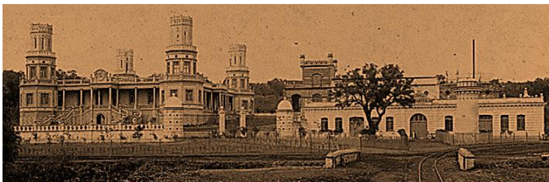
Imagen 73. Trabajos de colocación de vías en la línea ferroviaria del norte del país y extensión de las vías ferroviarias a la hacienda de Xico, Valle de Chalco, Estado de México.
