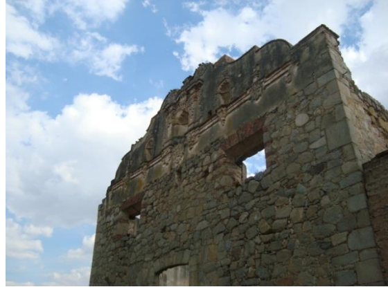
Imagen 203. Fachada principal de una de las tres capillas con remate mixtilíneo, la cual fue edificada casi en su totalidad con mampostería y en algunas secciones con adobe. Fuente: Imágenes de autor.
