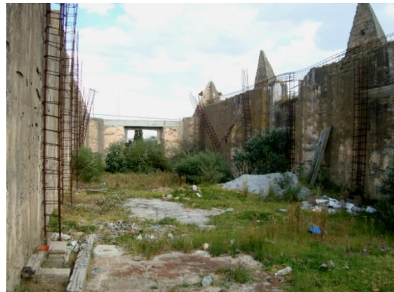
Imagen 208. Fachada y vista interior de la troje en la hacienda San Antonio Mazapa que actualmente se encuentra sin cubierta y se intentó intervenir en algún momento con concreto, ya que tiene el armado de unos castillos en el interior.
