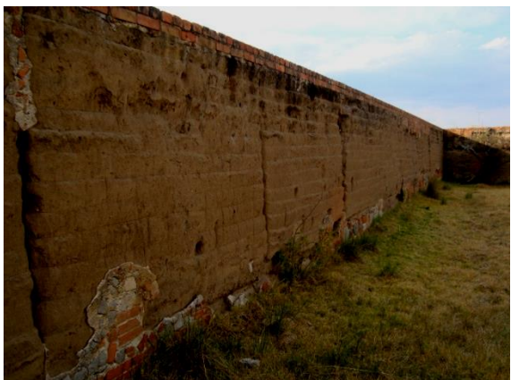
Imagen 115. Muros perimetrales edificados con tapia en la hacienda San Antonio Mazapa, Calpulalpan, Tlaxcala.
