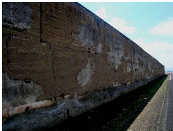
Imagen 116. Muros perimetrales edificados con tapia en la hacienda San Nicolás el grande, Benito Juárez, Tlaxcala.
