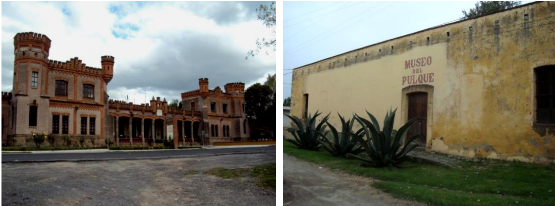
Imagen 187. Fachada principal de la hacienda con torreones de tabique y arcada central, del lado izquierdo tiene los tinacales que posteriormente se convirtieron en el museo del pulque y actualmente se están acondicionando para albergar habitaciones del hotel.
