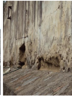
Imagen 196. Muros de tapia con pérdida de recubrimientos de mampostería y aplanados en las zonas de servicios de la hacienda Soltepec. Fuente: Imágenes de autor.
