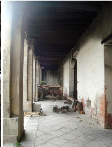
Imagen 205. Interior de la casa grande que se encuentra deteriorada, ha sido saqueada y ha perdido cubiertas, puertas, ventanas y secciones de muros. Fuente: Imágenes de autor.
