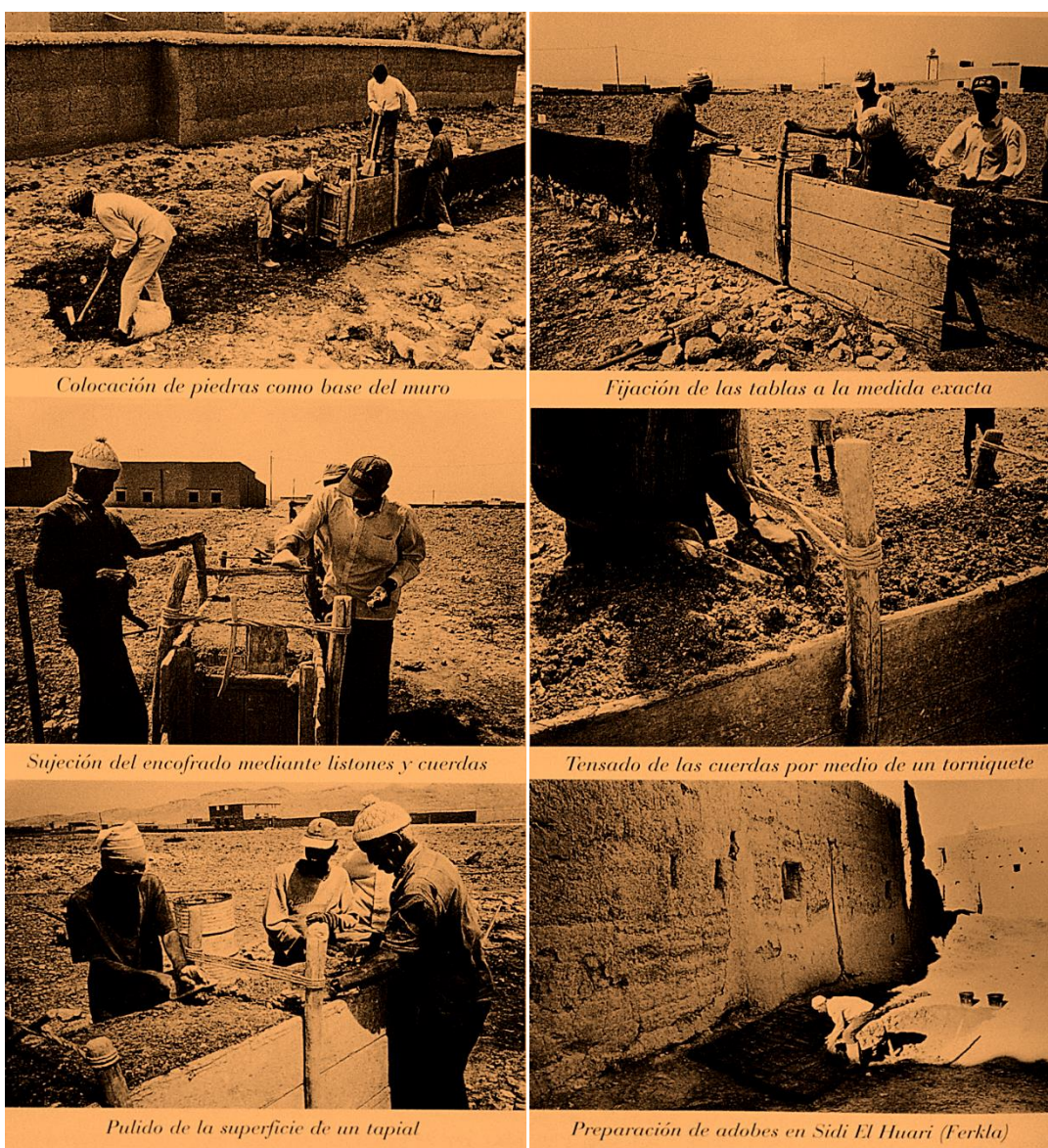
Imagen 6. Procedimientos para la construcción de muros de tapia.
