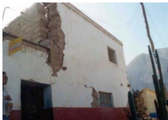
Imagen 230. Comportamiento de inmuebles edificados con tapia ante fenómenos sísmicos.
