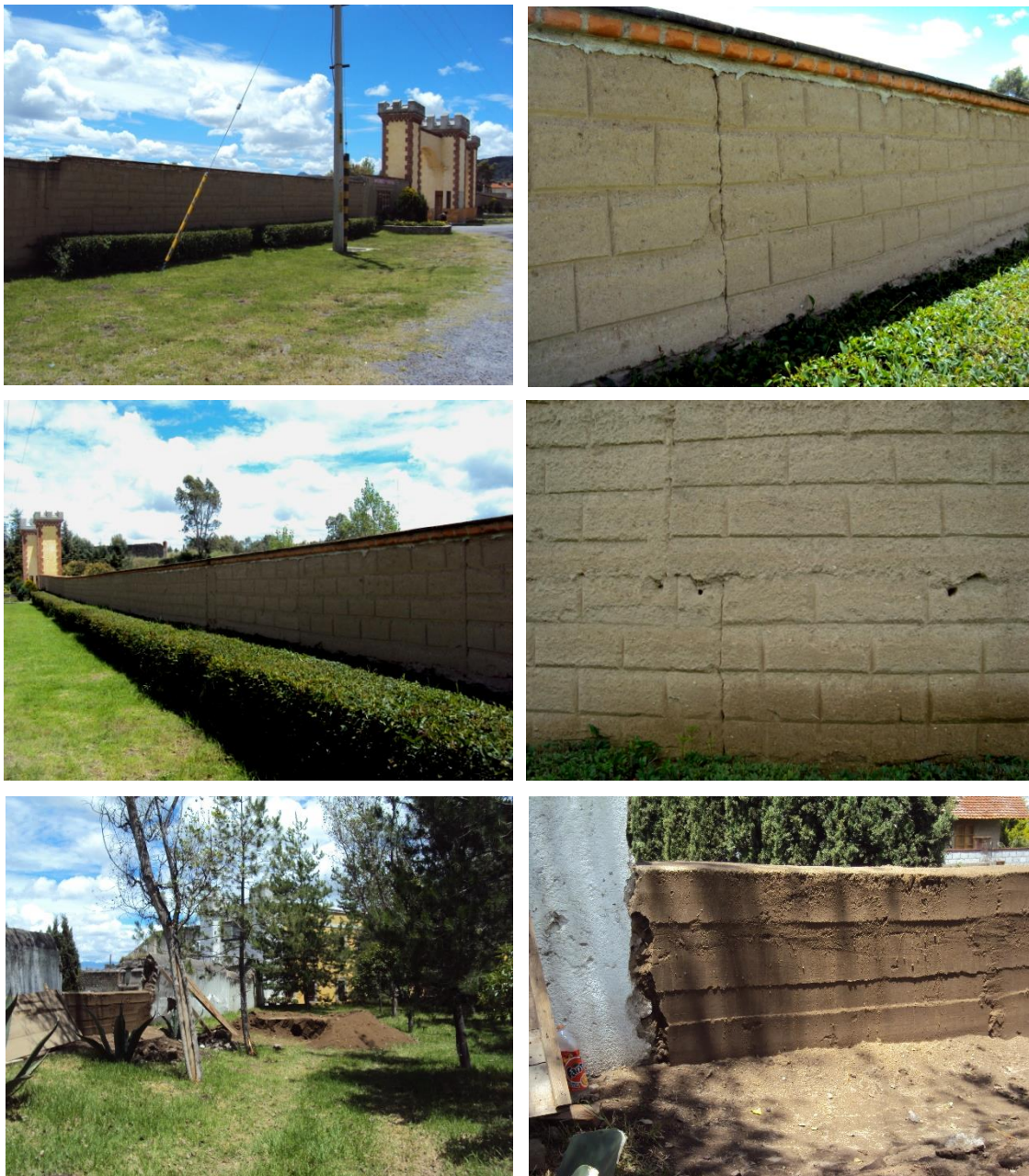
Imagen 213. Muros modernos edificados con el sistema constructivo de tapia en los terrenos de la hacienda San Francisco Soltepec, Huamantla, estado de Tlaxcala, para los que se utilizó la materia prima del sitio.
