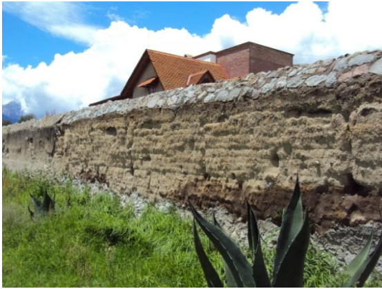
Imagen 195. Estado de conservación de los muros de tapia que han perdido los aplanados y se erosionan día con día en la hacienda San Francisco Soltepec, Huamantla, Tlaxcala. Fuente: Imágenes de autor.
