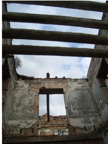
Imagen 205. Interior de la casa grande que se encuentra deteriorada, ha sido saqueada y ha perdido cubiertas, puertas, ventanas y secciones de muros. Fuente: Imágenes de autor.
