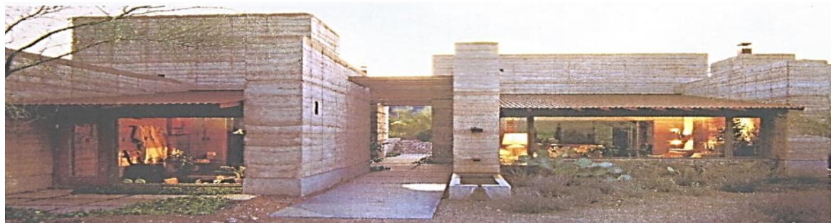
Imagen 225. Residencia Tucson, Arizona, Estados Unidos, conformada por tres elementos cúbicos en los que los muros, cuyo grosor es de 60 cm. cubren la cubierta inclinada. En los cerramientos se utilizó cemento mezclado con la tierra para dar mayor durabilidad.
