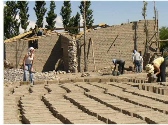
Imagen 239. Construcción de muros con tierra cruda utilizando materiales de origen natural.
