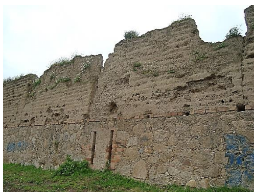
Imagen 231. Vulnerabilidad y deterioros de la arquitectura de tierra por falta de mantenimiento.
