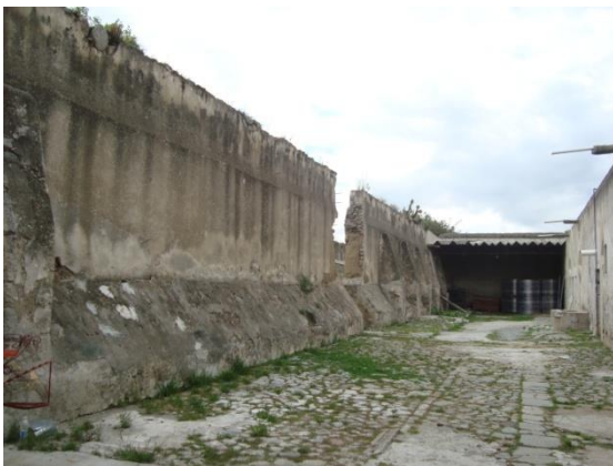
Imagen 194. Presencia de tapia en los muros de la hacienda San Francisco Soltepec, Huamantla, Tlaxcala.
