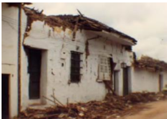
Imagen 230. Comportamiento de inmuebles edificados con tapia ante fenómenos sísmicos.
