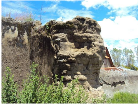
Imagen 195. Estado de conservación de los muros de tapia que han perdido los aplanados y se erosionan día con día en la hacienda San Francisco Soltepec, Huamantla, Tlaxcala. Fuente: Imágenes de autor.
