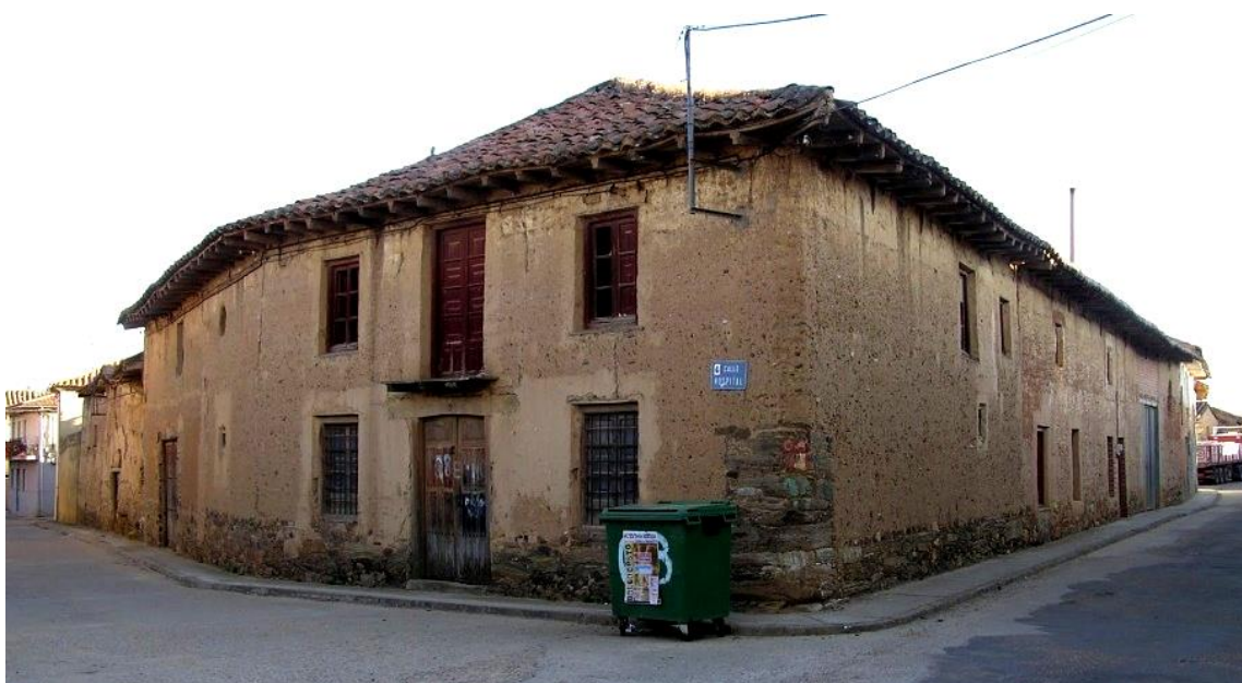
Imagen 41. Casa antigua construida con piedra y tapial en el centro de Coomonte de la Vega, España. Fuente: Patrimonio popular en: http://epmencia.blogspot.mx/2011_08_01_archive.html (2012)
