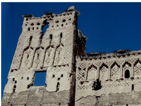
Imagen 30. Ornamentos en los remates de los muros de adobe, realizados con adobes para lograr la geometría de las figuras.
