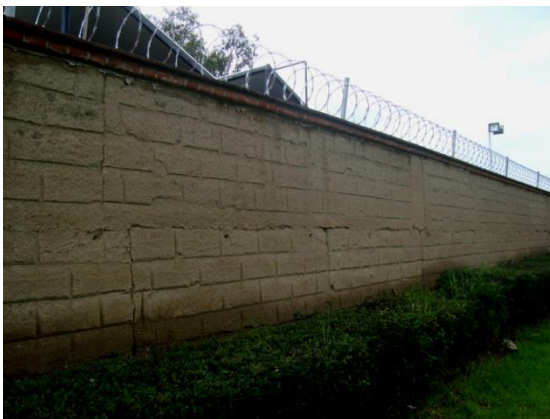
Imagen 197. Uso de tapia en construcciones modernas. El muro perimetral del nuevo fraccionamiento se erigió con tapia, la cimbra se colocó con textura para dar la impresión de sillares. Fuente: Imágenes de autor.
