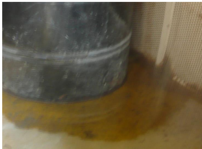
Figura 3.23. Antigua Subestación de CCH.
