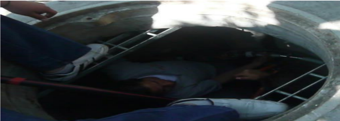
Figura.3.18. Fácil acceso a los registros que contienen los cables de energía.
