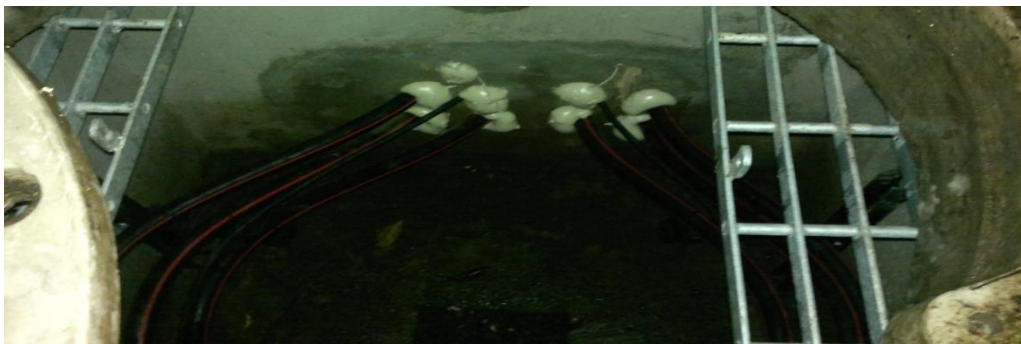
Figura 3.11. Conductores agrupados en modo adecuado.
