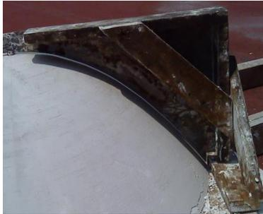
**Figura 3.14. Perfil del paraboloides.**
