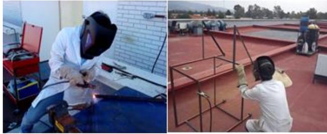
**Figura 3.29. Proceso para soldar el soporte.**
