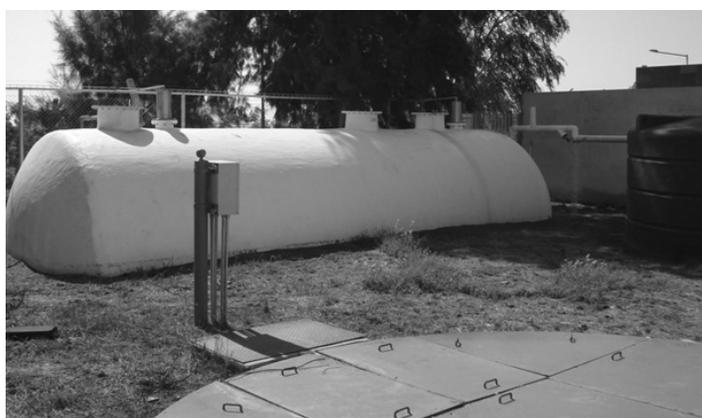
**Figura 2.3.- Biodigestor horizontal trabajando en régimen semicontinuo.**
