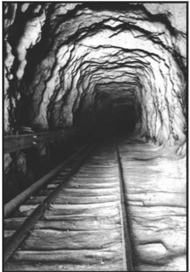
Fotografía 50: Imagen de una entrada de mina, en las paredes se observan el trabajo realizado por el hombre devastando a pico y cincel durante décadas causando este efectos de contraste entre claros y oscuros, técnica nitrato de plata, años 20, material CIHV.
