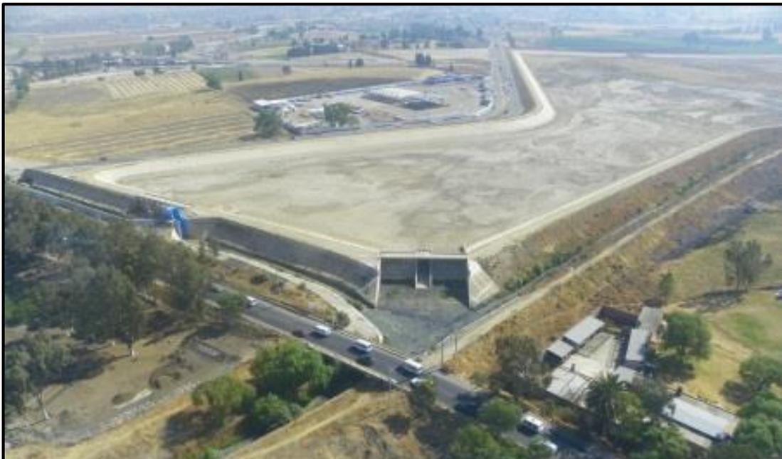
Figura 3.4. Laguna de regulación “La Gasera”.
