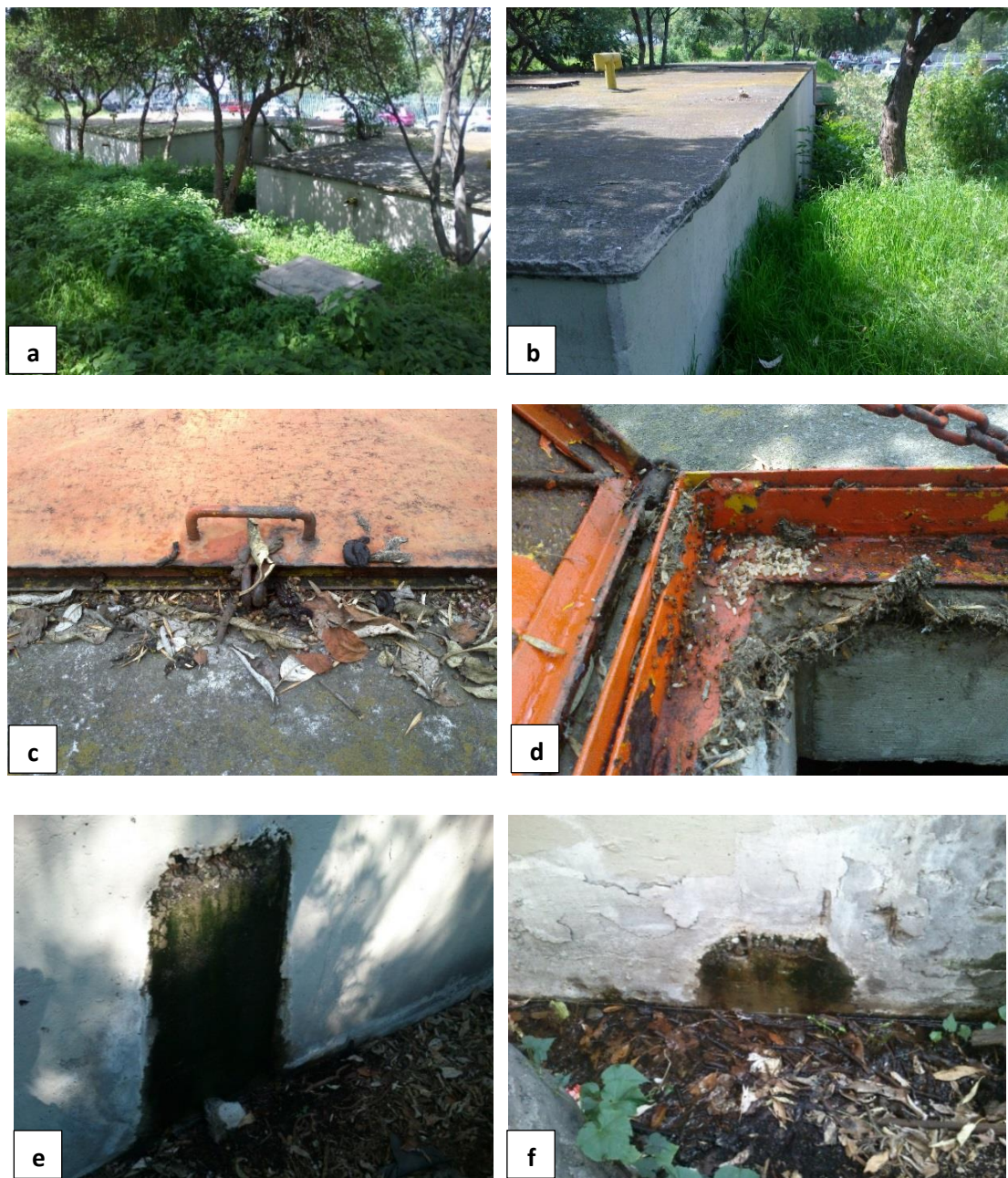
Figura 3 a, b, c, d, e, f. Cisterna Camellón Veterinaria
