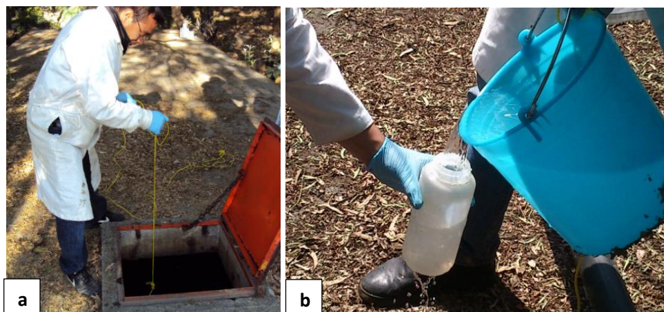
Figura 7 a, b. Muestreo en cisternas de agua residual tratada
