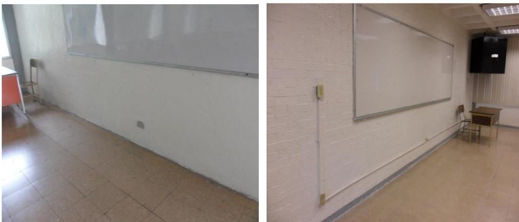
Figura 3.5 Contactos eléctricos edificio A1 FES Aragón.
