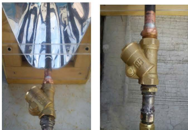
Figura 3.9 Válvula check de paso conectada al prototipo del CPC.
