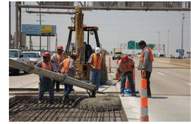
Concreto Región Central del Norte 45 plantas
