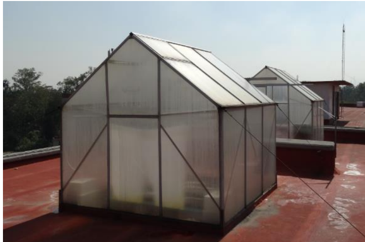
Figura 8.1. Casetas de desalinización solar.
