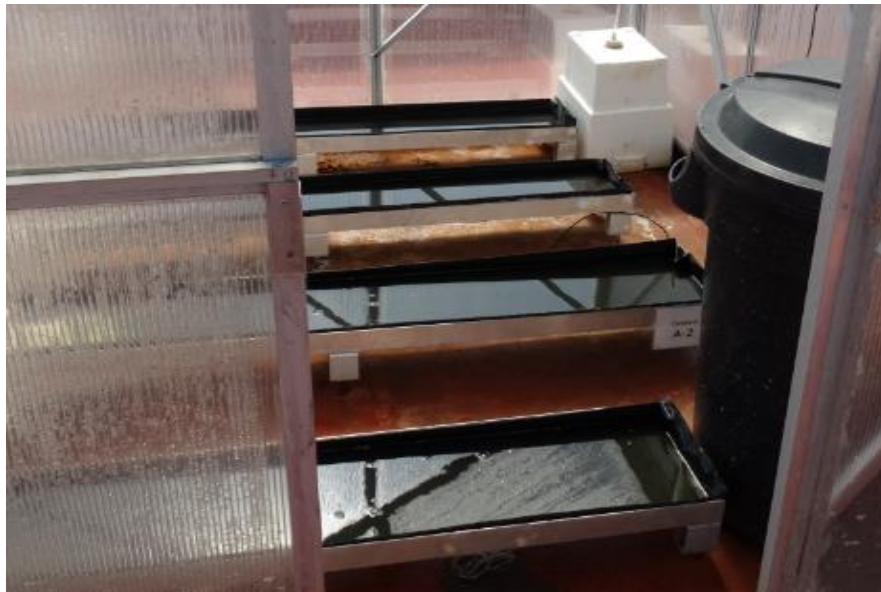
Figura 8.3. Canaletas para el agua cruda.
