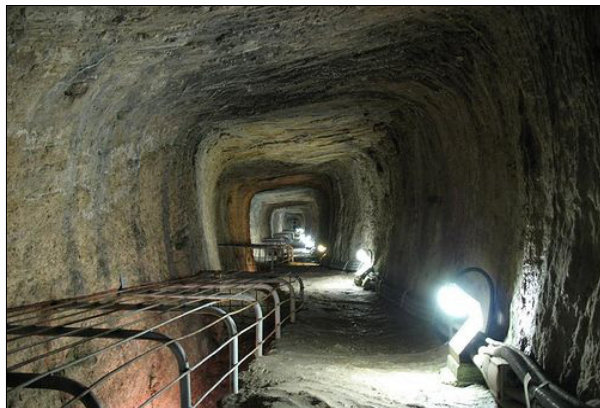
Figura II. Túnel en la isla de Samos, Grecia.
