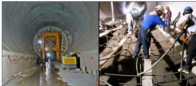
Figura 5.9 Revestimiento de sección circular en una zona del Túnel de desvío No. 2, en la construcción de la C. H. La Yesca. Izquierda: Revestimiento de la parte superior de la sección, primera etapa; Derecha: colocación de concreto en la plantilla de la sección, segunda etapa del revestimiento.
