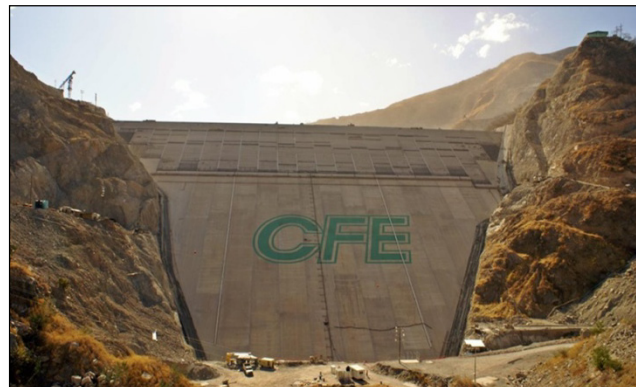
Figura 6.4 Cortina de la C. H. La Yesca durante su construcción. Vista aguas arriba (cara de concreto).
