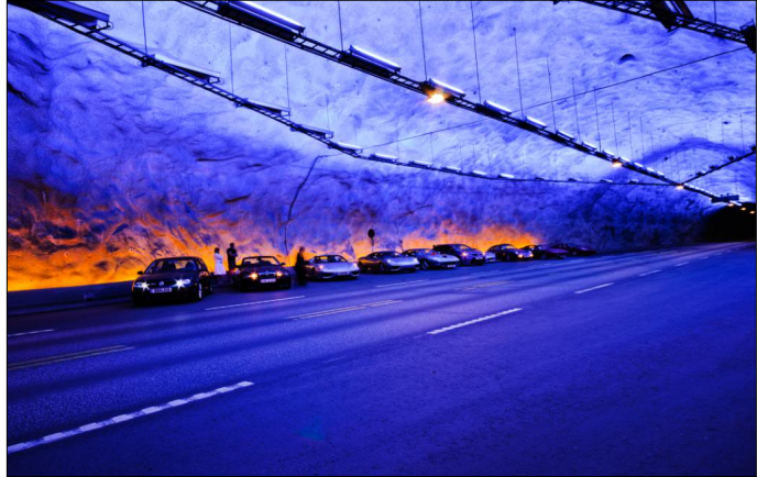
Figura XII. Túnel de Laerdals en Noruega. Es el túnel carretero más largo del mundo con 24.5 km, su construcción se terminó en el 2000. Incluye tres grandes cuevas distribuidas por su recorrido, con un tamaño e iluminación que permiten descansar la vista y romper la monotonía en los usuarios.
