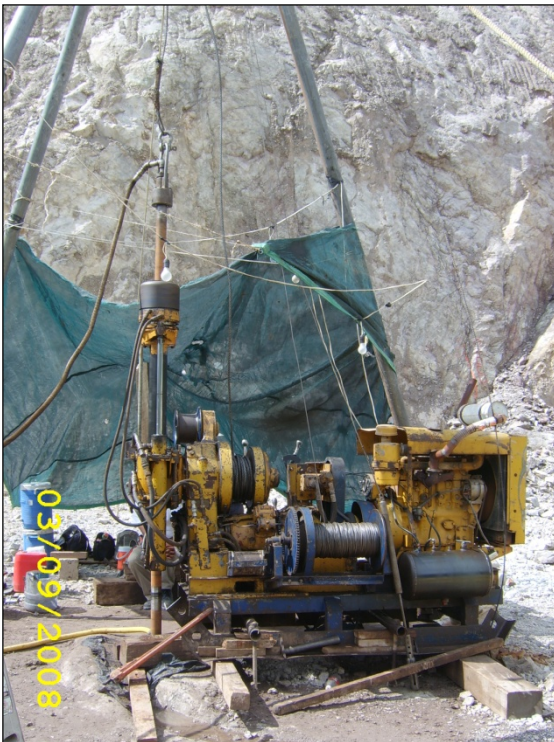
Figura 2.4 Perforación a rotación, equipo ligero sobre patines utilizado en la construcción de la C. H. La Yesca.
