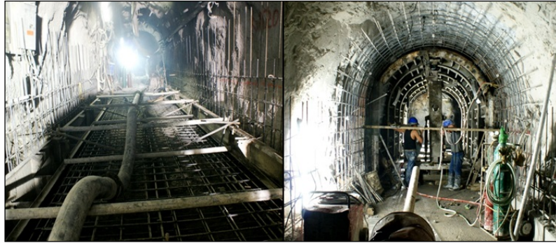
Figura 5.10 Revestimiento de sección portal, en una de las galerías para tratamiento del macizo rocoso, en la construcción de la C. H. La Yesca. Izquierda: Plantilla y arranque de muros listos para la colocación de concreto, primera etapa; Derecha: cimbra metálica posicionada para revestimiento de muros y bóveda, segunda etapa.
