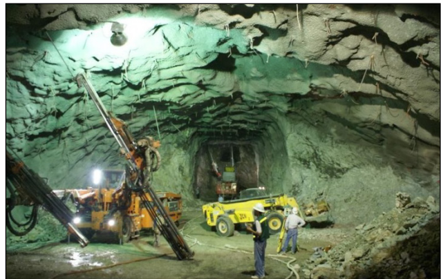
Figura 6.15 Excavación de la bóveda de la Casa de Máquinas. Se observa el avance de la excavación en las etapas ya descritas, con la galería central y los desbordes laterales desfasados algunos metros. Al fondo en la galería central se encuentra un Jumbo de tres brazos perforando los barrenos para la colocación de anclaje, y al inicio de la parte lateral izquierda de la bóveda, un Jumbo de dos brazos perforando barrenos para drenaje.
