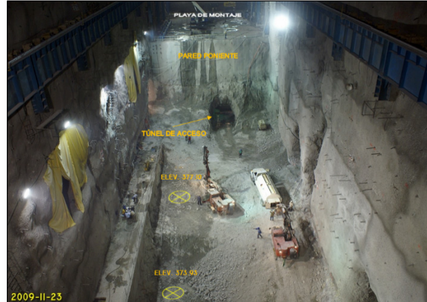
Figura 6.26 Sexto banqueo de la Casa de Máquinas. Se observa al fondo la entrada del túnel de acceso por la pared oriente.
