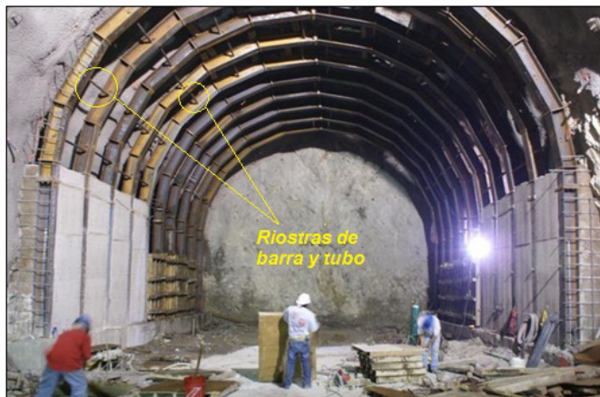
Figura 4.22 Riostras colocadas entre marcos de acero de perfil IR, retacados con concreto hidráulico, en la construcción de túnel de sección portal, para el acceso a la casa de máquinas de la C. H. La Yesca.
