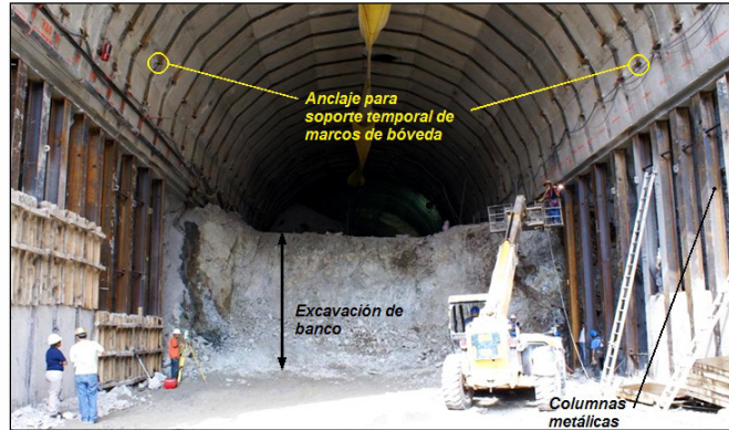
Figura 4.23 Colocación de marcos metálicos en dos etapas, la primera con la excavación de la bóveda, y la segunda con la excavación de banco, en la construcción del túnel de desfogaje de la C. H. La Yesca. Se observa que la excavación de banco se realiza un vez que han sido retacados con concreto los marcos de la bóveda.
