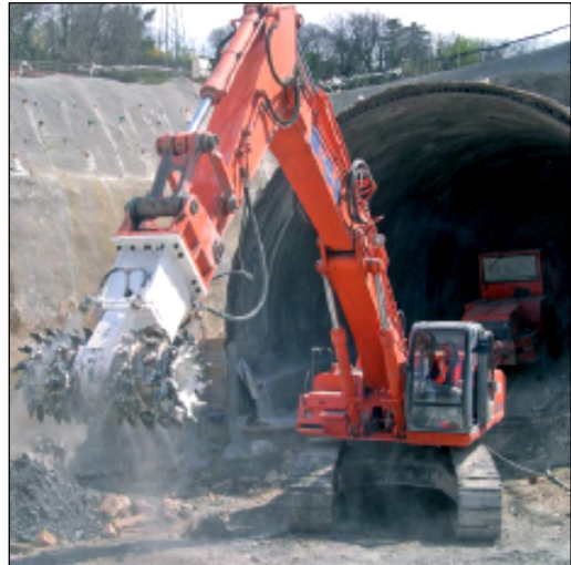
Figura 3.66 Excavadora portando una cabeza rozadora de eje transversal. [101] Sandvik.
