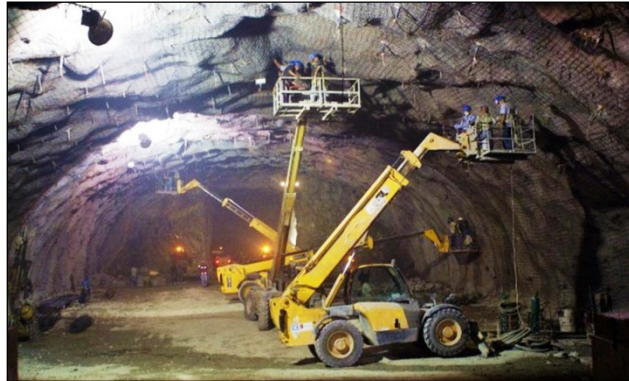
Figura 6.17 Colocación de la malla electrosoldada en la bóveda de la Casa de Máquinas, con la ayuda de manipuladores telescópicos.
