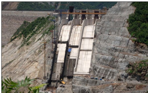
Figura 6.5 Canales de descarga de la Obra de excedencias de la C. H. La Yesca durante su construcción.
