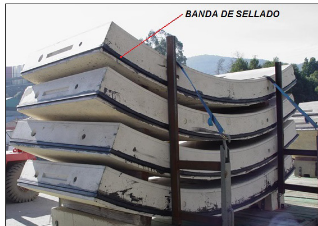
Figura 5.23 Dovelas de concreto, donde se aprecia la banda perimetral de sellado.
