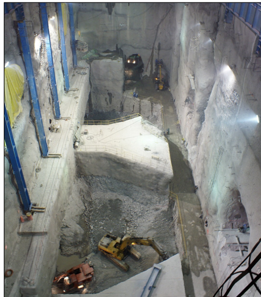
Figura 6.28 Excavación de los fosos de turbinas. Etapa final.
