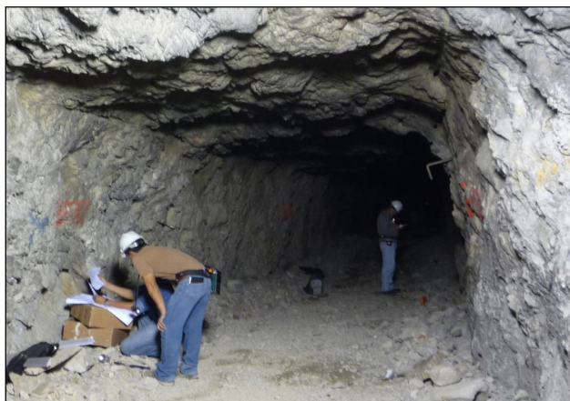
Figura 2.3 Socavón exploratorio por el eje de la Casa de Máquinas en la construcción de la C.H. La Yesca.
