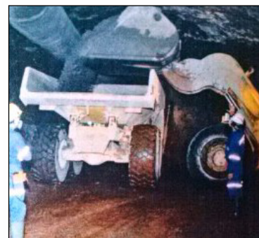
Figura 3.4 Retiro de rezaga en el interior de un túnel con la ayuda de un cargador frontal y camión articulado.
