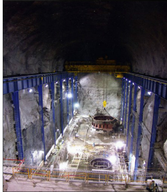
Figura XIV. Montaje de una turbina en la caverna de Casa de Máquinas del Proyecto Hidroeléctrico El Cajón, México. Ésta estructura subterránea de 23 m de ancho, 50 m de alto y 104 m de largo se excavó en un tiempo de 11 meses.
