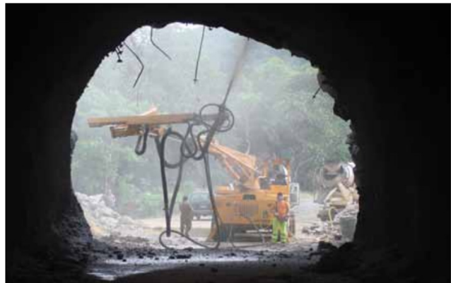
Figura 4.17 Equipo robotizado para la colocación de concreto lanzado. [79] Sika AG (2011).
