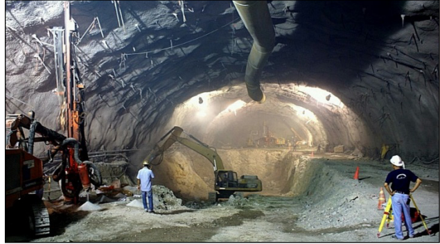
Figura 6.19 Inicio de la excavación del primer banco. En la imagen se observa una excavadora con martillo hidráulico perfilando el muro aguas abajo de la caverna.
