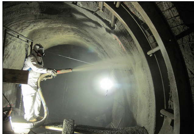
Figura 4.11 Colocación manual de concreto lanzado dentro de un túnel.
