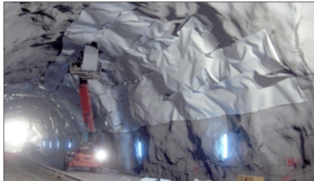
Figura 5.16 Colocación de geotextil en todo el contorno de la bóveda de la excavación. [98] OSSA.
