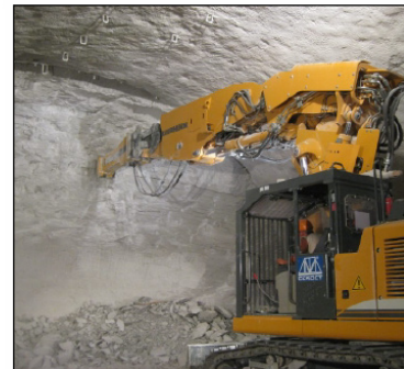
Figura 3.3 Amacice del terreno, después de realizada la voladura.
