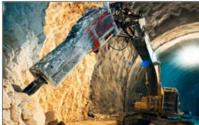
Figura 3.65 Excavadora portando un martillo hidráulico. [101] Sandvik.
