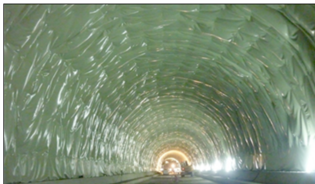
Figura 5.17 Membrana de impermeabilización colocada en el contorno de la excavación. [98] OSSA.
