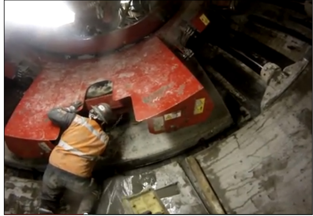
Figura 3.52 Colocación de dovela con la ayuda del erector en una tuneladora tipo Escudo. [105] Tunnel.
