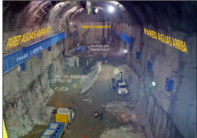
Figura 6.23 Tercer banqueo de la caverna de la Casa de Máquinas. Se observa al fondo la playa de montaje, y en las paredes algunas piezas ya colocadas que servirán para el apoyo de la grúa viajera.
