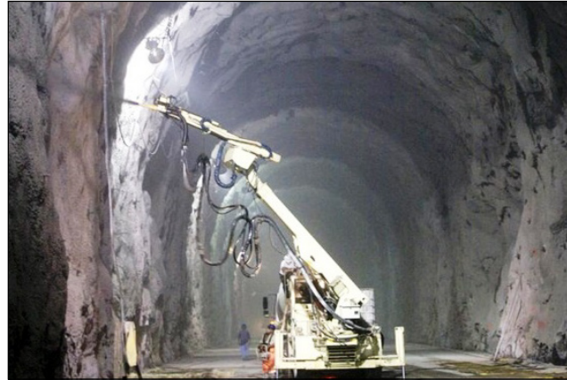
Figura 5.3 Colocación de segunda capa de concreto lanzado para revestimiento definitivo en uno de los túneles de desvío, en la construcción de la C. H. La Yesca.
