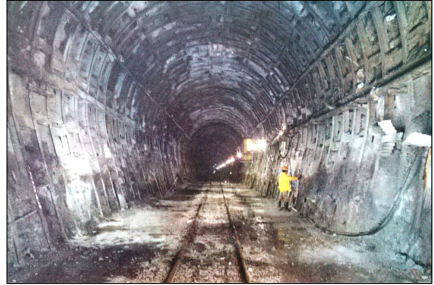
Figura VI. Túnel para el drenaje profundo de la Ciudad de México. [31] Departamento del Distrito Federal Vol. 3.
