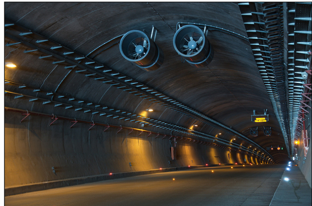
Figura 5.8 Revestimiento definitivo de concreto armado, colado in situ, en el túnel carretero El Sinaloense, México. [97] Obrasweb.
