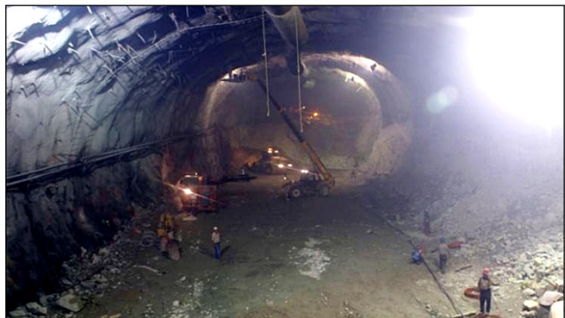
Figura 6.20 Excavación del primer banco de la caverna de la Casa de Máquinas.
