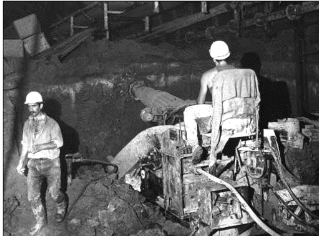
Figura XI. Rozadora MK2A marca Dosco, utilizada en Inglaterra en los primeros intentos para excavar el túnel del Canal de la Mancha. [104] The History Press .
