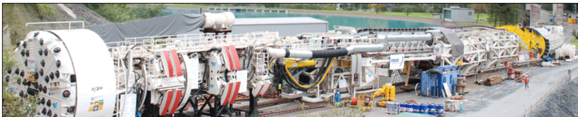
Figura 3.50 Tuneladora tipo topo de doble gripper utilizada en la construcción de un túnel para la planta hidroeléctrica Linthal en Suiza. En la foto se aprecia parte del equipo de apoyo. [100] Rowa Tunneling Logistics .
