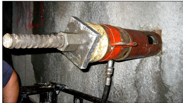
Figura 4.9 Tensado de ancla en el muro de un túnel con gato hidráulico.
