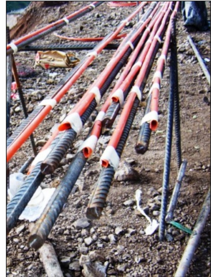
Figura 4.6 Anclas de acero con la manguera de plástico sujeta en ellas. Utilizadas en la construcción de la C. H. La Yesca.
