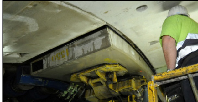
Figura 5.22 Colocación de una dovela con ayuda del brazo erector de la tuneladora. [92] Geocontrol .
