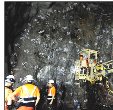
Figura 3.2 Colocación de explosivos en los barrenos perforados.
