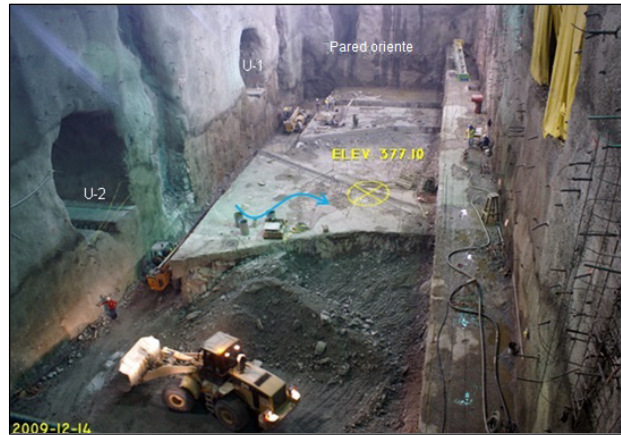
Figura 6.27 Excavación de los fosos de turbinas. Se observa del lado izquierdo (pared aguas arriba), la entrada de los túneles para las tuberías a presión.
