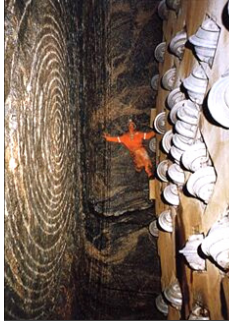
Figura 3.46 Frente del túnel donde se aprecian los círculos formados en la roca por los cortadores de disco en la cabeza del topo. [99] Robbins Europa.
