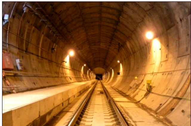
Figura 5.18 Revestimiento definitivo con dovelas en el túnel ferroviario de Guadarrama, España. [92] Geocontrol
