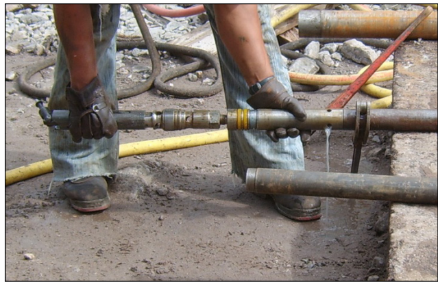
Figura 2.6 Sistema Wire Line.
