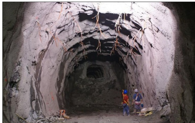
Figura 6.14 Túnel de acceso a la bóveda de la Casa de Máquinas. Se aprecia al fondo el socavón piloto excavado en la clave, para la auscultación del macizo rocoso.
