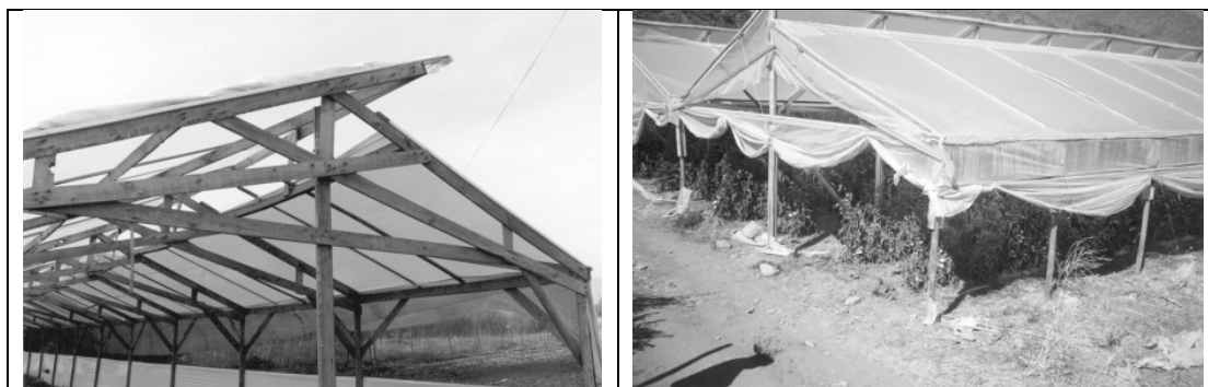
Figura 36 - Abertura cenital (Izq), Ventilación lateral en horas de calor (Der).
