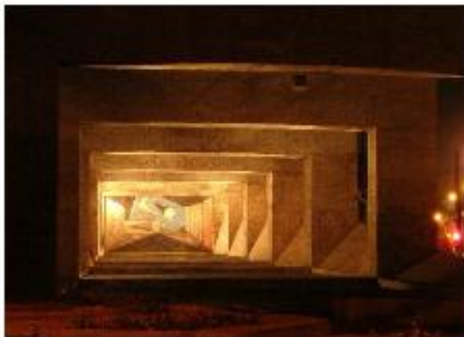
Figura 58. Vista hacia el interior
