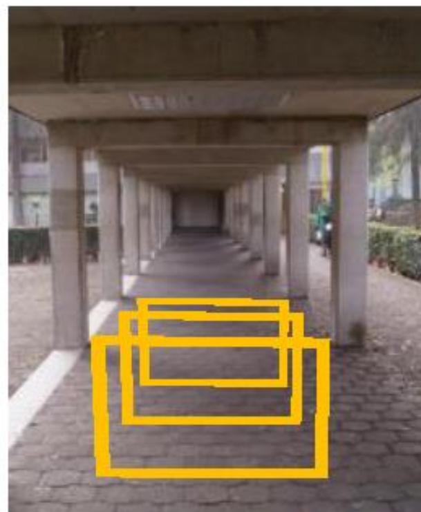
Figura 125. Anamorfosis de los cuadros verticales. Paso peatonal a cubierto entre los edificios A4 y A6. FES Acatlán.
