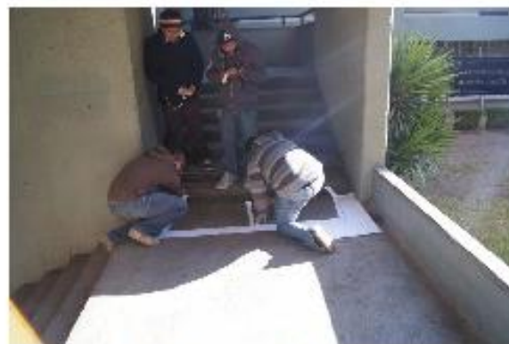
Figura 100. Instalación de los componentes de la plantilla in situ . Equipo dos.
