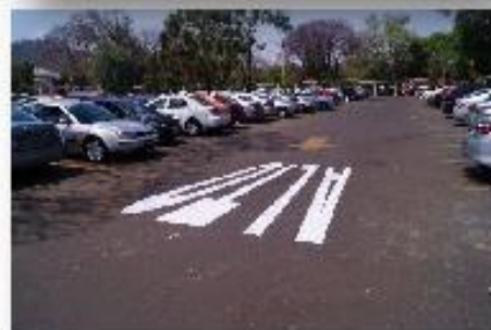
Figura 201. Ejemplo anamórfico. Desde el punto de vista del conductor el aviso se percibe sin deformaciones. Fotografías tomadas en el estacionamiento de la FES Aratán
