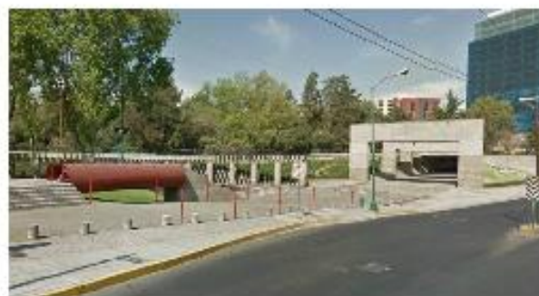
Figura 57. Vista del conjunto, Plaza Rufino Tamayo
