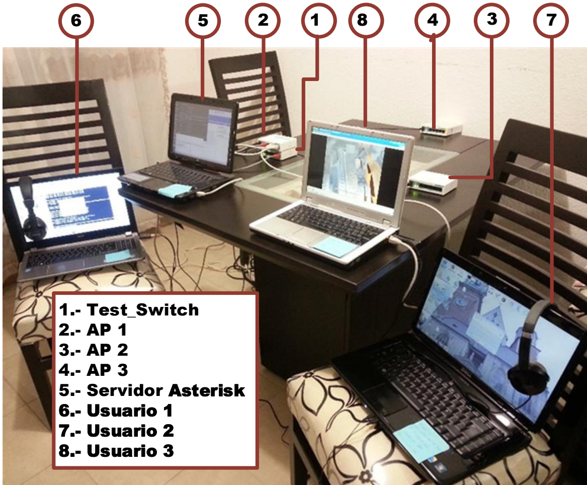
Figura 4.7. Laboratorio físico de la red inalámbrica mesh parcial.
