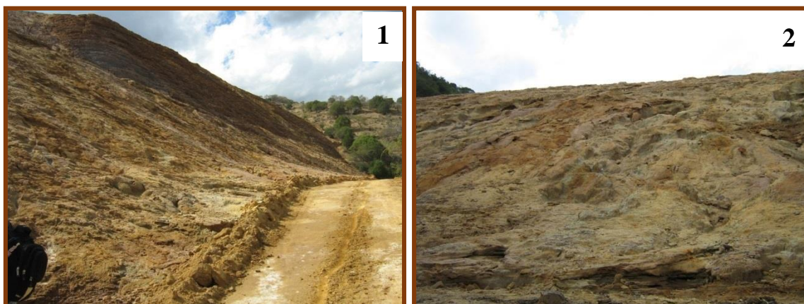
Fotos 1 y 2. Depósito de jales El Fraile I y El Fraile II.
