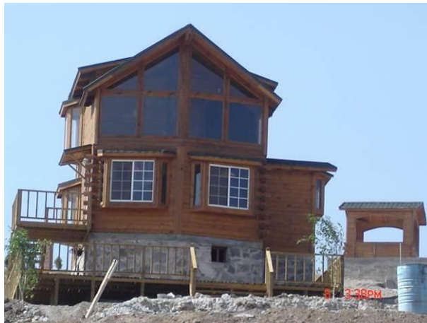
Ilustración 1 Construcción del fraccionamiento
