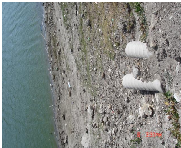
Ilustración 5 Drenaje dirigido directamente a la Presa
