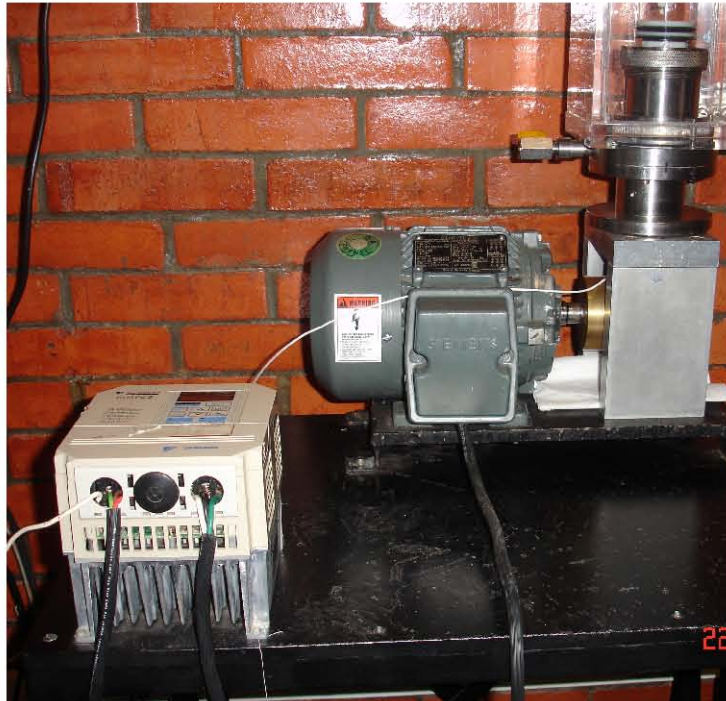
Figura 2.8: Fotografía del regulador de frecuencia y el motor acoplados al segundo sistema experimental.
