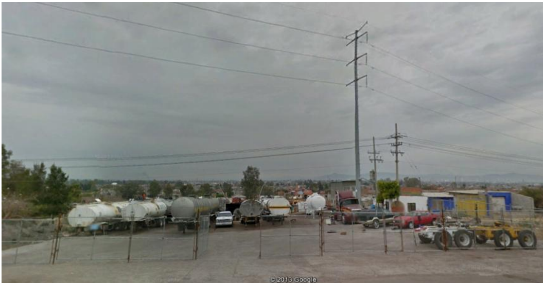
Figura 5.8 Vista de Vaporizaciones , ubicada en Salamanca, Guanajuato. (Fuente: GoogleEarth)
