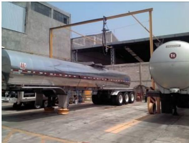
Figura 5.7. Lavadero 5, área de vaporizado.
