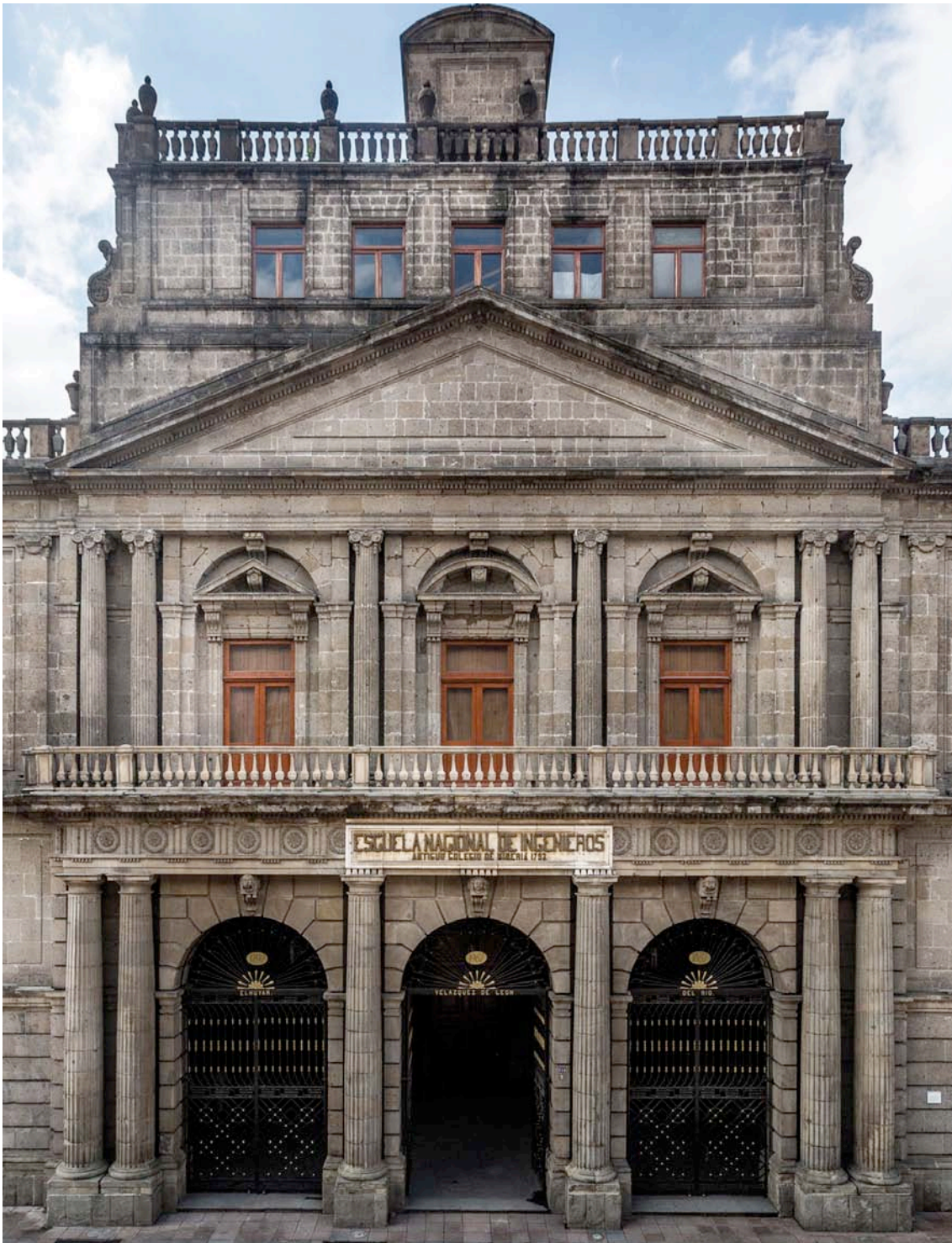
Fig. 4. La relación entre el Tribunal de Minería y Tolsá, se concretó con el inicio de la construcción del Real Colegio de Minería, gracias a este vínculo, el cuerpo minero logró construir un inmueble que representara la importancia de la corporación minera, pero sobre todo, el poder de sus directores. Por su parte, con esta obra el escultor transitó hacia el campo de la arquitectura, cuestión insólita para un artista académico.
