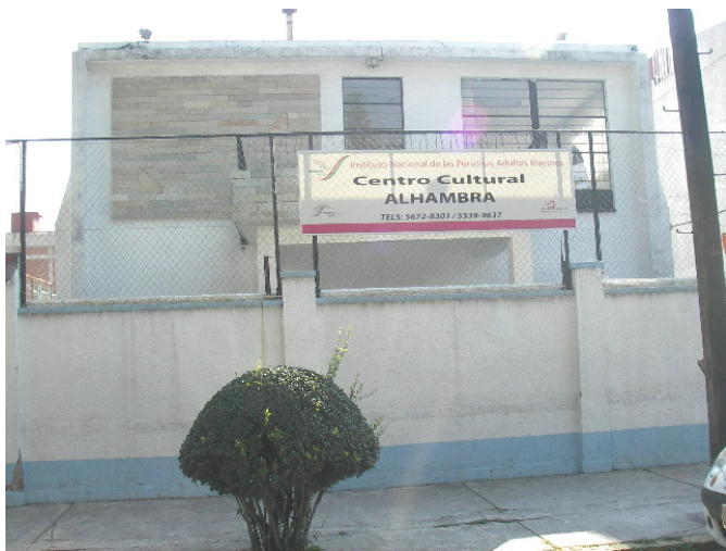
Fachada del centro.
