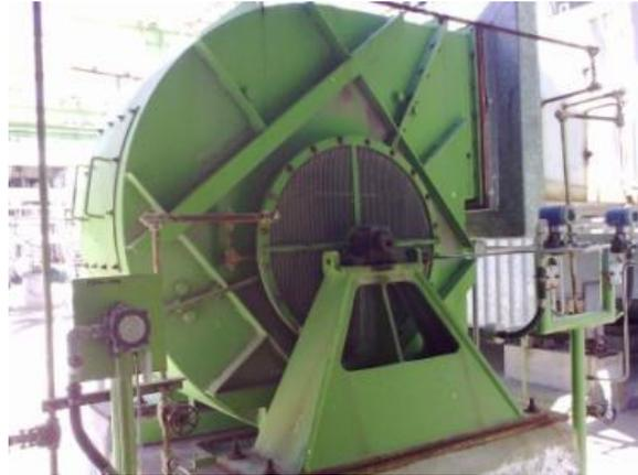
**Figura 3. 5 Ventilador de tiro forzado.**
