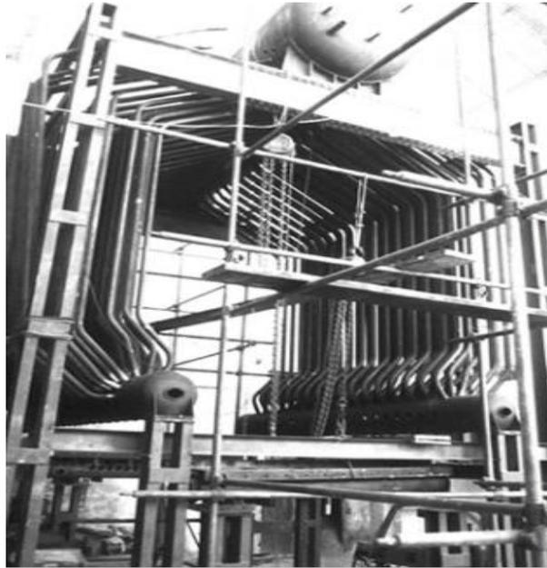
**Figura 1. 32 Sobrecalentador de un generador de vapor.**
