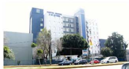
11 El hospital Regional 1° de octubre consta de ocho niveles. La fachada está revestida con paneles laminados en blanco y azul. Predomina el vano sobre el macizo.
