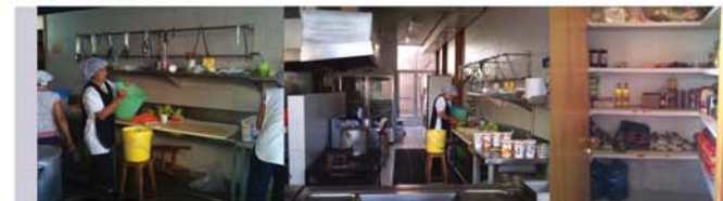
Cocina. La cocina es un espacio considerable para la elaboración de alimentos de 150 personas aproximadamente. Cuenta con zona fría, zona caliente, zona de preparación y alacena.
