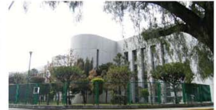
8 Este edificio es el Hospital Benito Juárez. Consta de tres niveles. El material utilizado en fachada es panel de concreto. Se modula una franja de vano por una de macizo.
