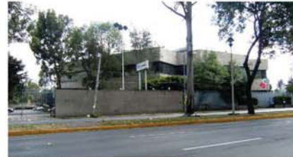
7 En la esquina surponiente del terreno se encuentra este edificio, el cual es un edificio de Telmex. Es de concreto aparente. Tiene muy clara la diferencia entre vano y macizo, ya que presenta una franja de vano por una de macizo. Consta de dos niveles.
