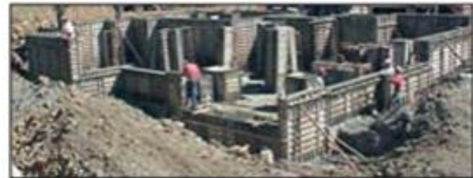
Colado de muros, trabes y columnas
