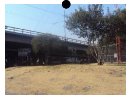
Bajo puente Ermita Iztapalapa
