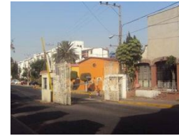
Acceso controlado a Colonial Iztapalapa
